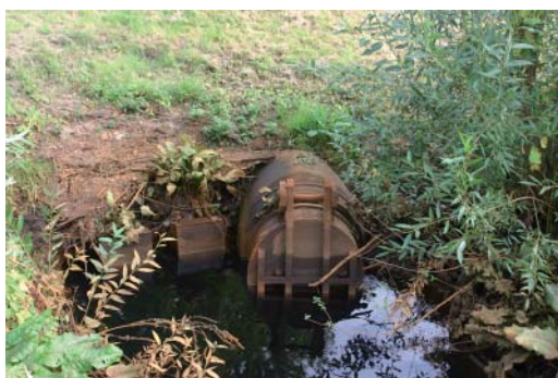
Grøftegennemløb i st. 37.
