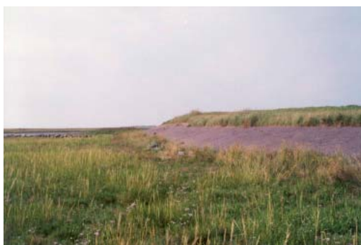
Digets forskråning. Asfaltbeskyttelse ved Kalvekrog.
