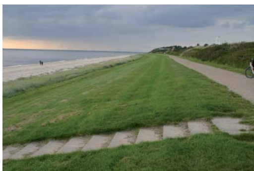
Betontrappe i st. 1487 set mod nordvest.
