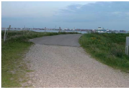
Rampe i st. 250 ved Nordby Dige, nord, set mod nordøst.
