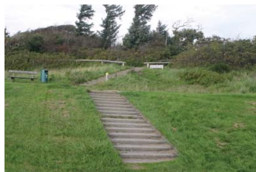
Betontrappe ved bådpladsen i st. 74.
