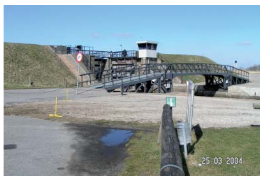
(6) Ribe Kammersluice set fra landsiden.
