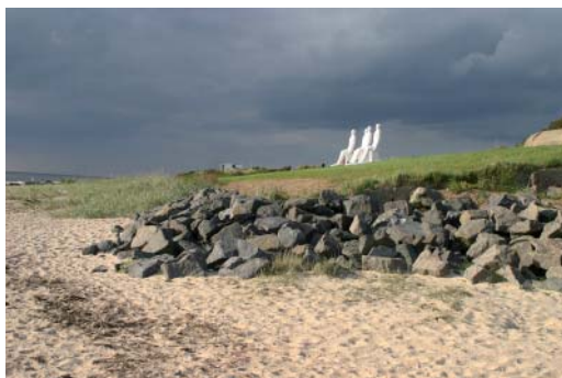
Sydlig afslutning af skræntfodsbeskyttelse (st. 0).
