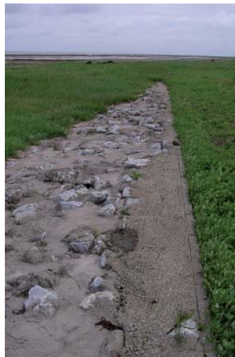
Skråningsbeskyttelsen på forskråning. Beskyttelsen af digefoden med granit/betonbelægning.
