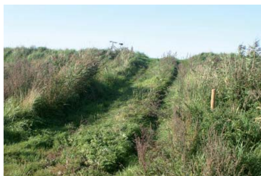
Vejrampe i st. 2350 set fra landsiden.
