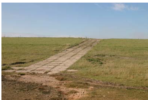
Rampe i st. 940 set fra havsiden.
