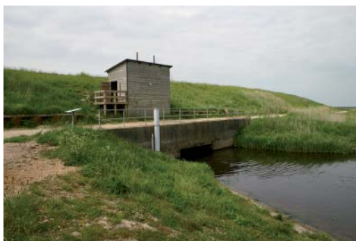
Rejsby sluse set fra landsiden.
