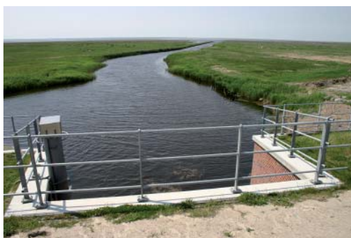
Udløbet af Brøns sluse mod havet.
