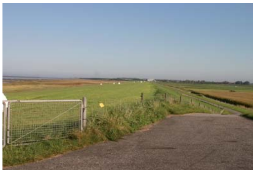
Rampe i st. 7.350 set mod nord.
