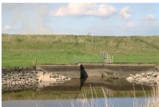
Sluse for afvanding i st. 6320 set fra havsiden.
