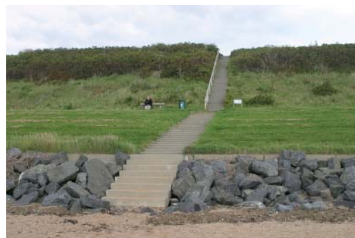
Betontrappe i st. 224.
