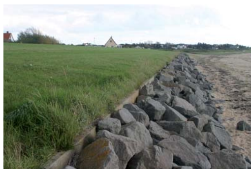
Skræntfodsbeskyttelsen set mod sydøst.
