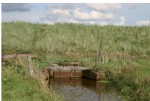
Rørgennemløb i st. 1900 set fra syd.
