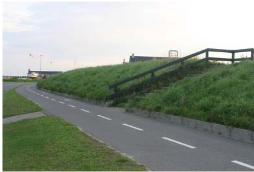
Trappe ved Svenservej set fra havsiden.
