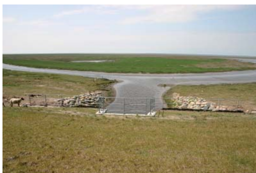
Udløbet af Råhede sluse mod havet.
