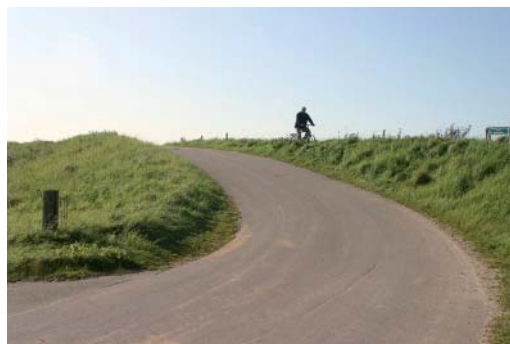
Vejrampe i st. 1350 set fra landsiden.
