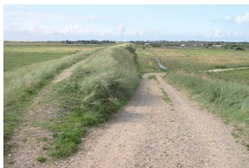
Rampe ved Grønnevej set fra øst.
