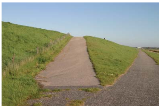
Rampe i st. 7.350 fra landsiden.
