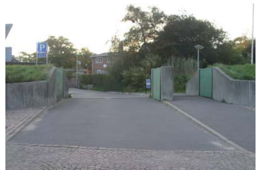
Højvandsporte ved Havnevej (Nordby Dige, By- og syd).
