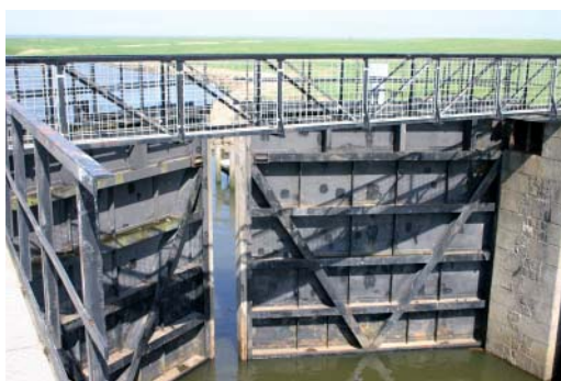
(9) Ydre sluseporte i Ribe Kammersluse.
