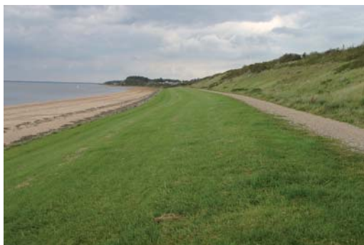
Hjerting Nord Skræntfodsbeskyttelse set mod nordvest.
