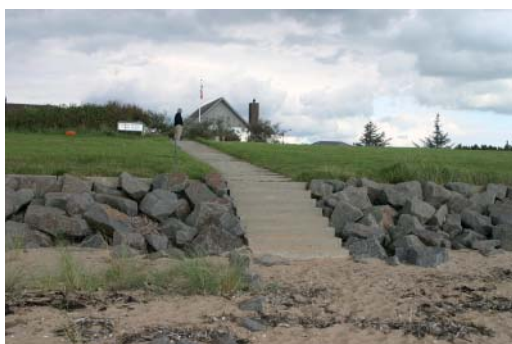
Betonstrappe i st. 407 set fra havsiden.
