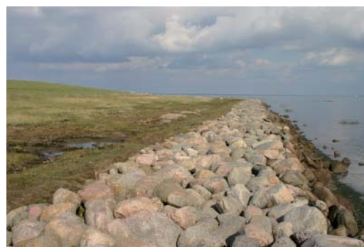
Fodsikring ved rampen i st. 940.
