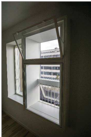
Figur 21. Støjdæpende multifunktionsvindue (billederne til venstre og i midten). Støjen dæmpes på vejen gennem åbningen for neden (udendørs) til åbningen for oven (indendørs). Til højre er vist en lydskodde, som er monteret foran et eksisterende vindue. Den dæmper støjen, men giver også adgang for frisk luft. Den kan desuden mørkelægge et rum, hvis det ønskes.
