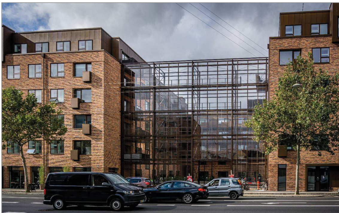
Figur 20. I denne nye bebyggelse, har man anvendt en støjskærm i åbningen mellem bygningerne for at opnå et lavt støjniveau i bebyggelsens gårdmiljø. I facaden mod vejen er der anvendt særligt støjdæmpende vinduesløsninger (Gl. Køge Landevej, København).
