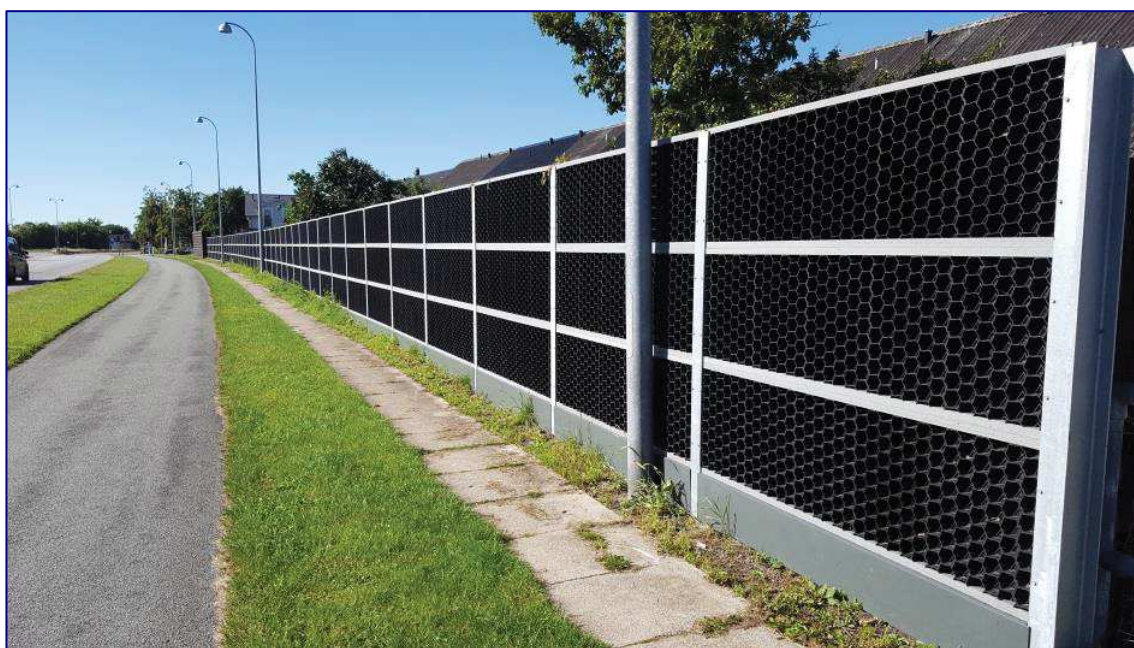
Figur 14. Eksempel på støjskærm langs et boligområde. De sorte akustiske elementer i skærmen består af materiale fra genbrugte vindmøllevinger (Vallensbæk).
