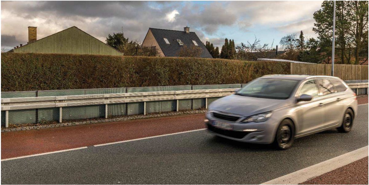
Figur 16. Autoværn, der er udformet som en lav støjskærm. Selvom skærmen er lav, kan der være en støjdempende virkning, fordi den står meget tæt på støjkilden.
