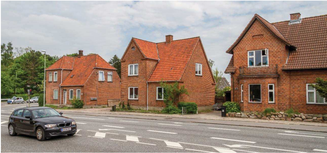
Figur 15. I mange tilfælde kan der ikke plads til en støjskærm langs vejen. Der kan også, som på billedet, være udkørsler fra boligerne, som vil blive blokeret af en støjskærm.
