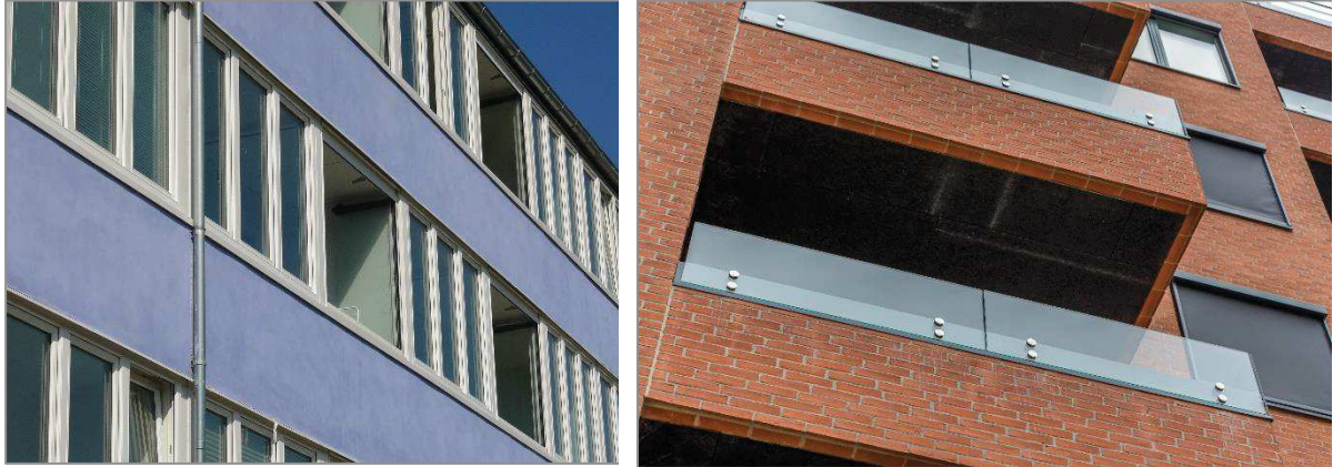
Figur 22. I ejendommen til venstre blev altanerne forsynet med en forsatsrude, der kan skydes til siden. Når ruden er lukket, fungerer den sammen med altanrummet som en meget effektiv støjdæmpning. Til højre er vist åbne altaner med en glasafskærmning, der begrænser støjen. Der er desuden et lydabsorberende akustikloft, som dæmper støjen i altanrummet.
