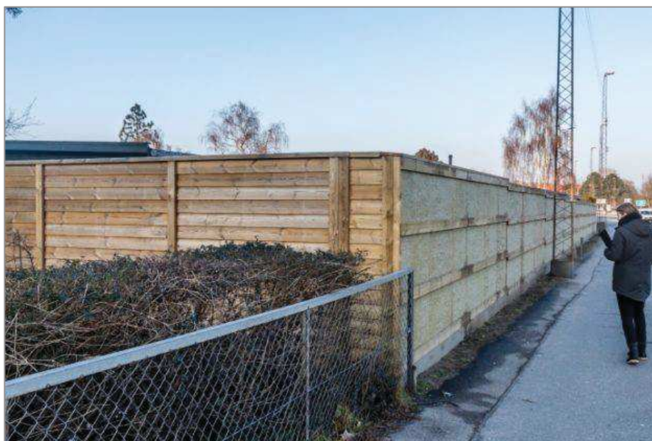
Figur 25. Her har grundejeren bygget sit eget støjhegn og brugt mineraluld på siden mod vejen. Hegnet har formentlig en god støjdæpende virkning fordi det er tæt, har en god højde og går op i skel vinkelret på vejen. Mineralulden har ingen betydning for hegnets støjdæpende virkning hos grundejeren.
