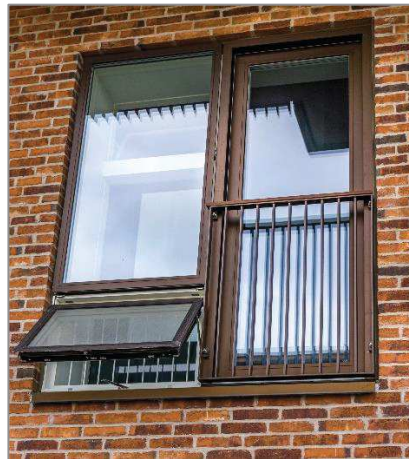
Figur 21. Støjdæpende multifunktionsvindue (billederne til venstre og i midten). Støjen dæmpes på vejen gennem åbningen for neden (udendørs) til åbningen for oven (indendørs). Til højre er vist en lydskodde, som er monteret foran et eksisterende vindue. Den dæmper støjen, men giver også adgang for frisk luft. Den kan desuden mørkelægge et rum, hvis det ønskes.
