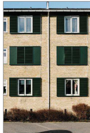
Figur 21. Støjdæpende multifunktionsvindue (billederne til venstre og i midten). Støjen dæmpes på vejen gennem åbningen for neden (udendørs) til åbningen for oven (indendørs). Til højre er vist en lydskodde, som er monteret foran et eksisterende vindue. Den dæmper støjen, men giver også adgang for frisk luft. Den kan desuden mørkelægge et rum, hvis det ønskes.
