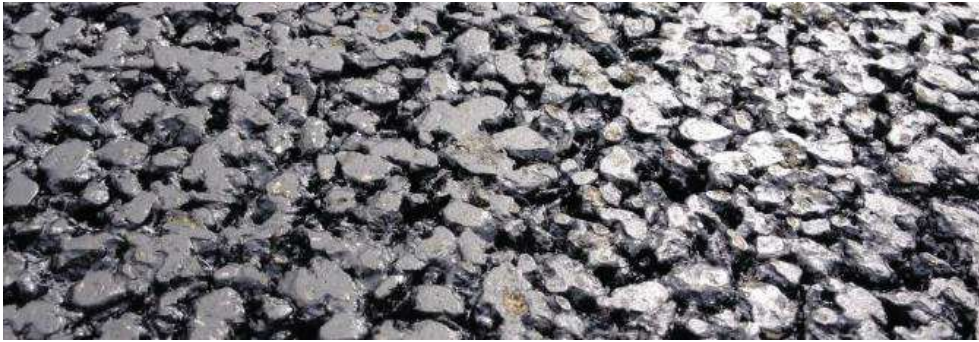
Figur 13. Nærbillede af et nyt og mindre støjende slidlag (teknisk betegnelse: SMA-8). Både den meget jævne og åbne overfladestruktur ses tydeligt. En traditionel belægning (f.eks. SMA-11) har en grovere og mere ujævn struktur.
