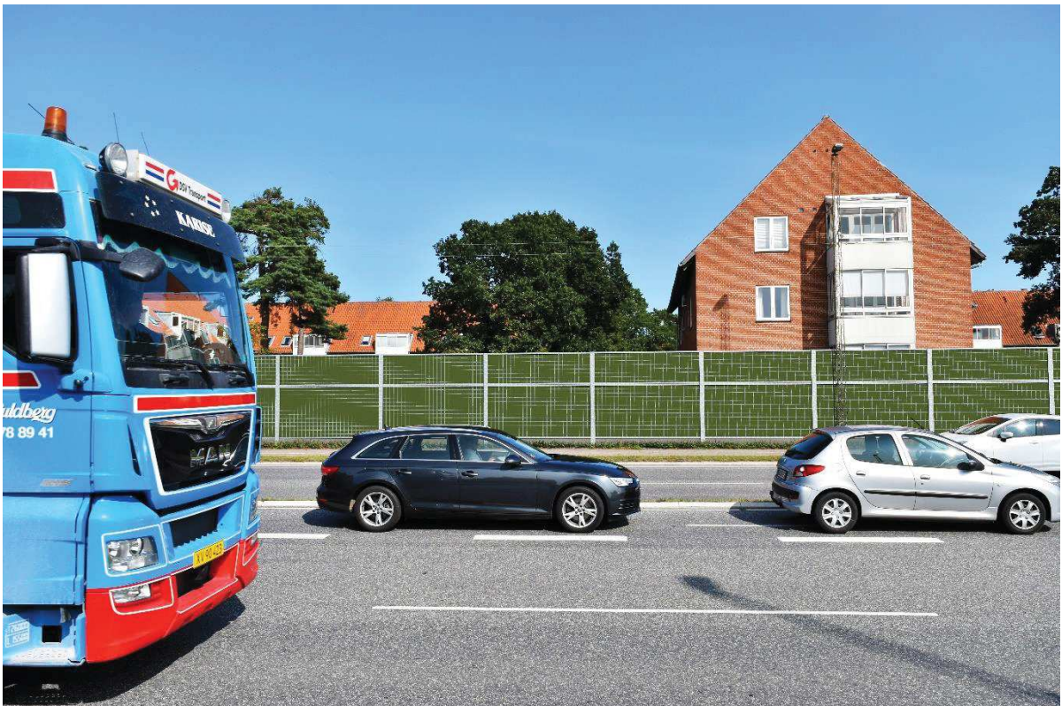
Figur 17: Eksempel på støjskærm ved et etageboligområde. Støjskærmen dæmper støjen på de udendørs opholdsarealer bag skærmen og for boligerne i stueetagen, men ikke for boligerne på 1. og 2. sal.
