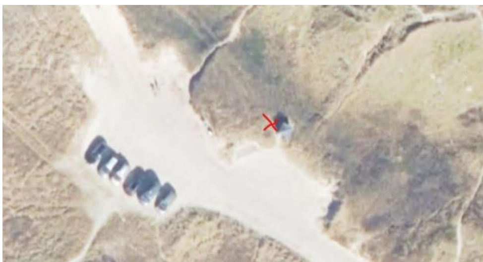
Fig. 2. Tilsendt fra ansøger. Det røde kryds markerer den ansøgte placering af vandtanken. Umiddelbart til højre for det røde kryds ses den eksisterende toiletbygning, der ønskes udskiftet med en nye toiletbygning på samme placering.
