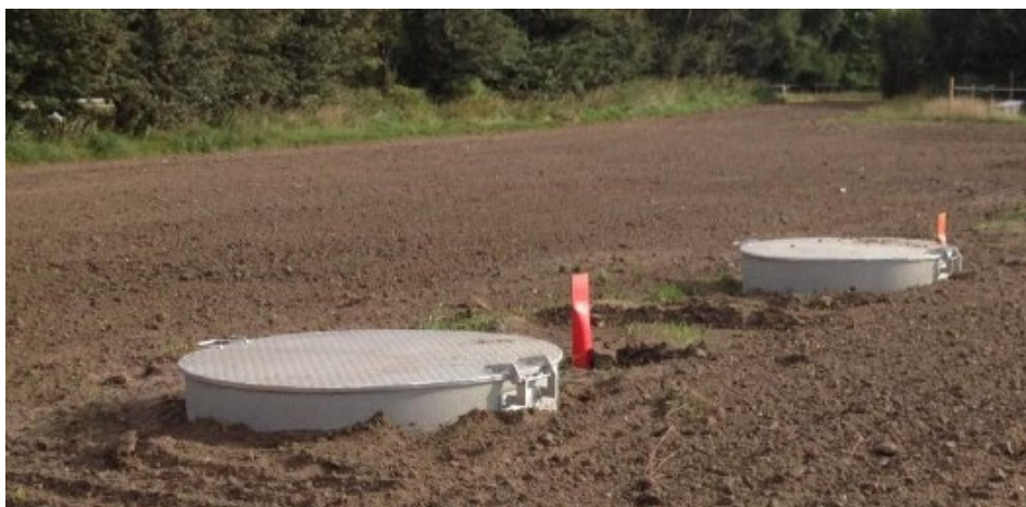
Figur 4. Billede fra ansøgningen. Eksempel på etableret linkboksbrønde og markeringspæle.
