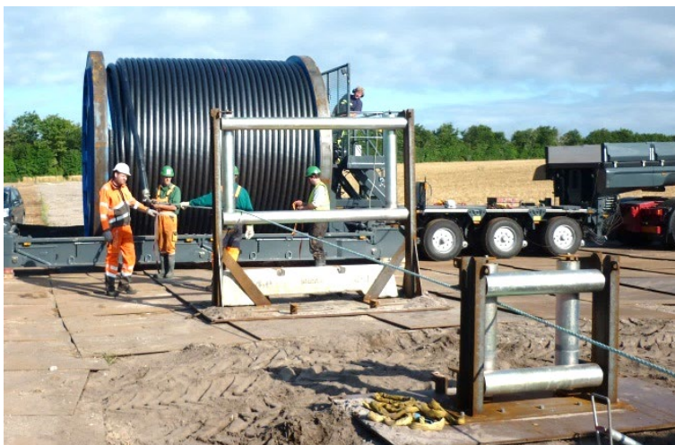
Figur 2-16 Kabeltromle på blokvogn
