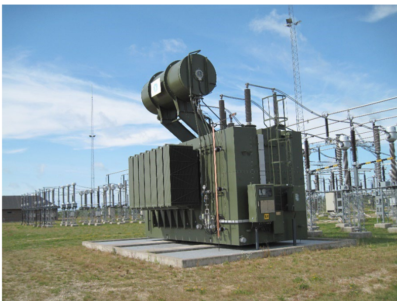
Figur 6-4. Eksempel på kompenseringspole.
