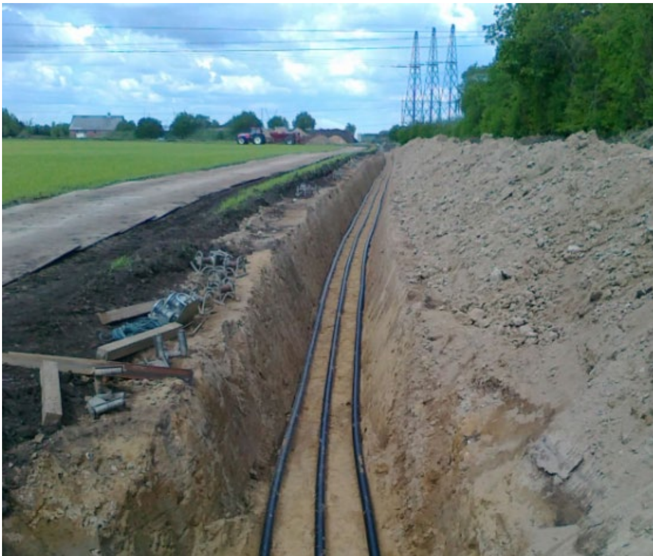
Figur 2-8 Eksempel på enkelttrace kabelanlæg lagt ud i åben grav
