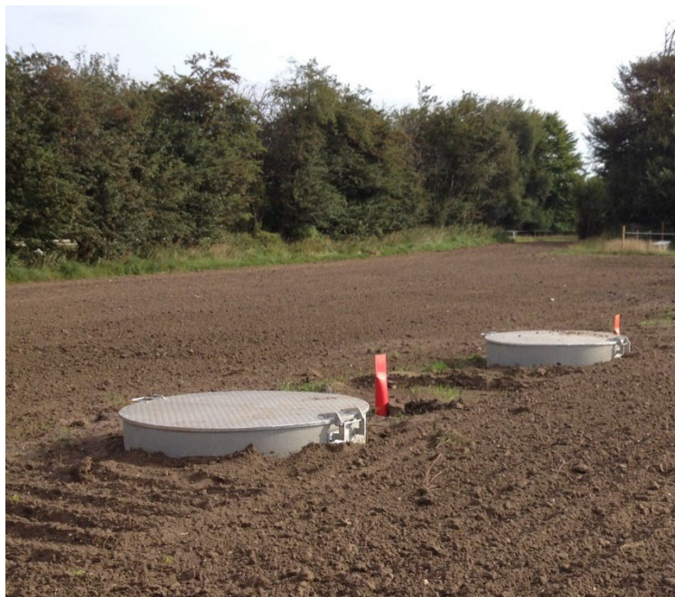
Figur 2-2 Eksempelfoto af linkbokse i terræn
