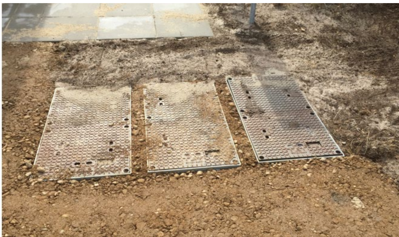
Figur 2-3. Eksempel på 3 stk. fiberbrønde.
