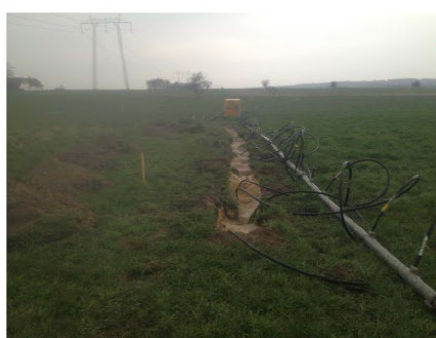
Figur 2-10 Forskellig metoder til at holde kabelgraven tør. På billedet til venstre etableres drænrør, til højre etableres sugespidsanlæg
