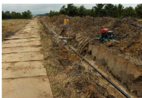
Figur 2-10 Forskellig metoder til at holde kabelgraven tør. På billedet til venstre etableres drænrør, til højre etableres sugespidsanlæg
