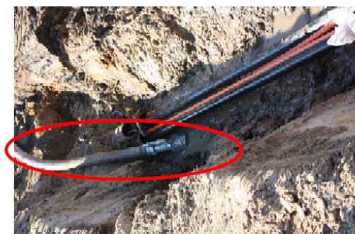
Kabelgraven pumpes med grundvandspumper
