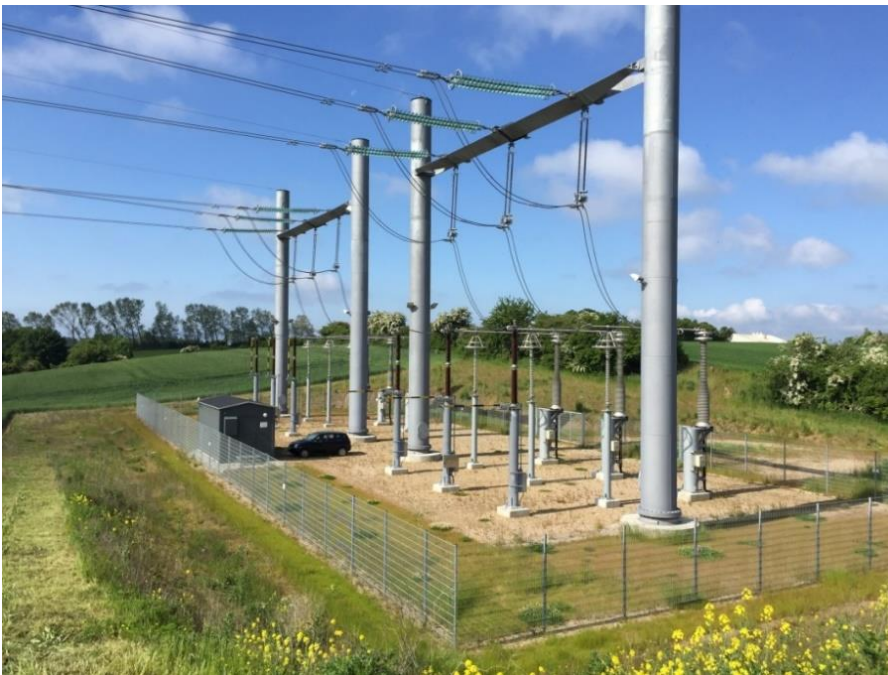
Eksempel på endetræksmaster på kabelovergang
