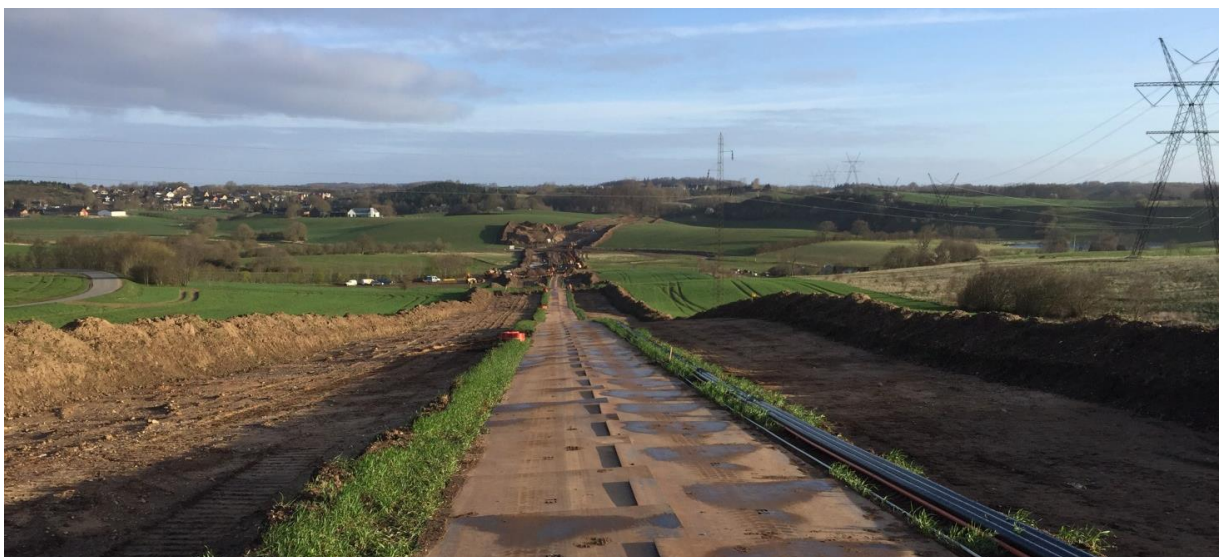
Eksempel på et afrømmet arbejdsbælte til dobbelt kabelgrav, lige inden gravning af selve kabelgravene. I dette projekt vil anlægsbæltet være ca. dobbelt så bredt, da der skal laves 4 kabelgrave.
