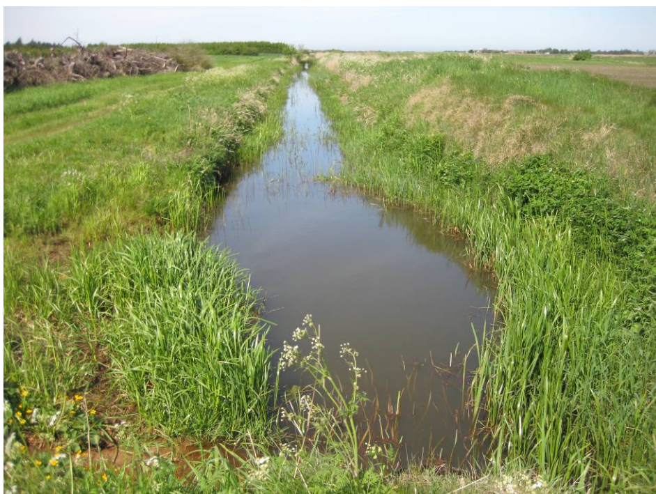
Kimmelkær Landkanal er en 2,7 km lang afvandingskanal afbrudt af korte rørlægninger hvor markveje krydser kanalen. Foto: Jørgen Lissner.
