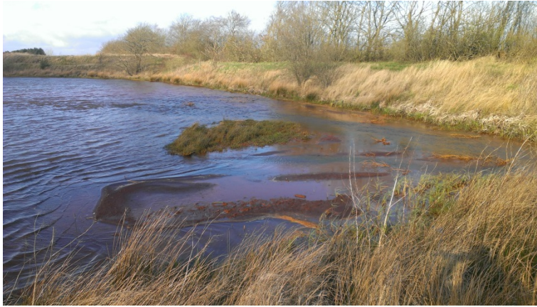
Figur 13. Tilslemning af bundfældningsbassin ved indløb-1 i Hoageranlægget. Foto: Forsmann, 2014.
