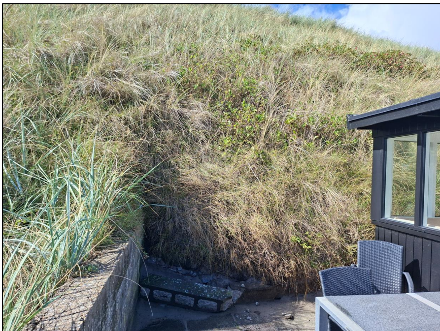
Fig. 4. Billede taget på besigtigelse af ejendommen den 9. september 2026. På billedet kan man se den væltede støttemur ved den sydlige del af sommerhuset.
