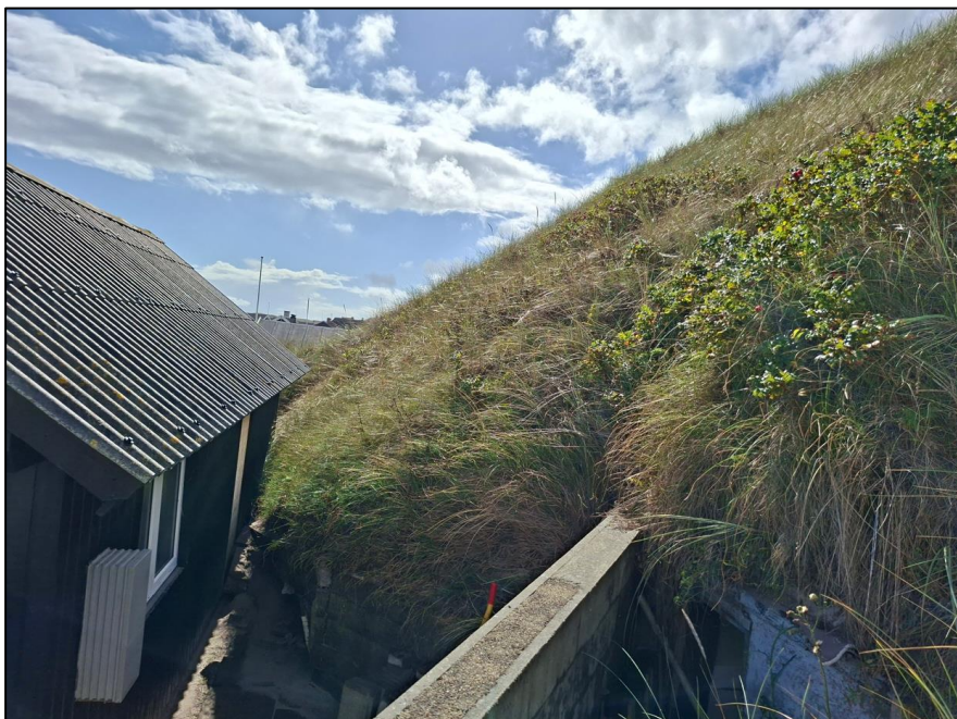
Fig. 7. Billede taget på besigtigelse af ejendommen den 9. september 2026. På billedet ses støttemur i midten og bygning nord for støttemuren (til højre).
