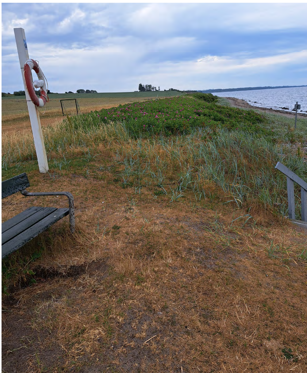
Fig. 2.3 Pæle og buske på diget svækker dets styrke og kan føre til digebrud under storm.
