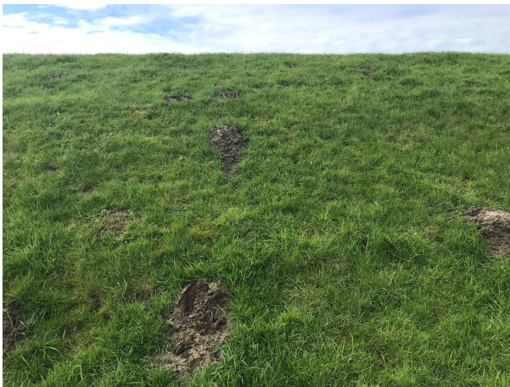
Fig. 2.6 Flittige muldvarpe og mosegrise kan hurtigt perforere digets græslag med masser af huller.
