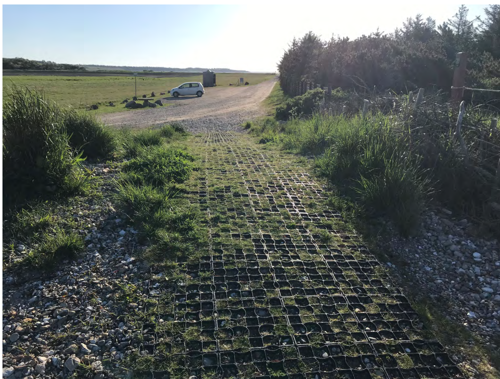
Fig. 3.1 Trapper og overgange svækker digets styrke.
