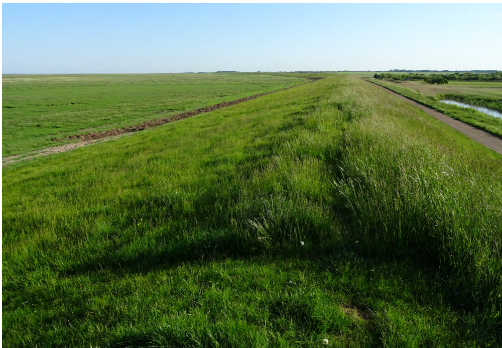
Fig. 2.4 Græslagets styrke er størst, når der ikke er anden bevoksning på diget.
