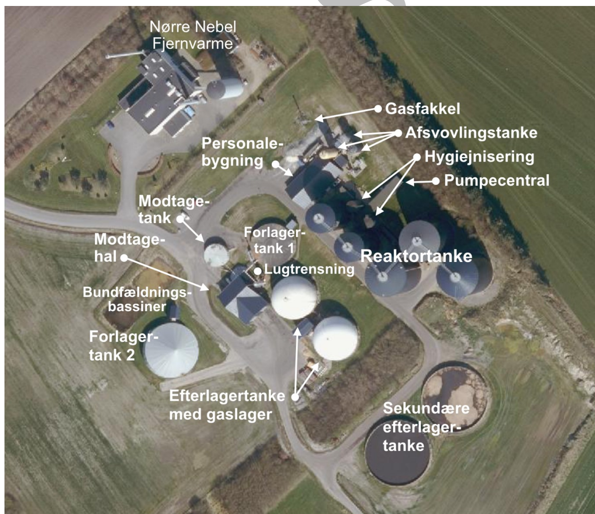
Figur 1 Luftfoto af det eksisterende biogasanlæg med nabovirksomheden Nørre Nebel Fjernvarme.
