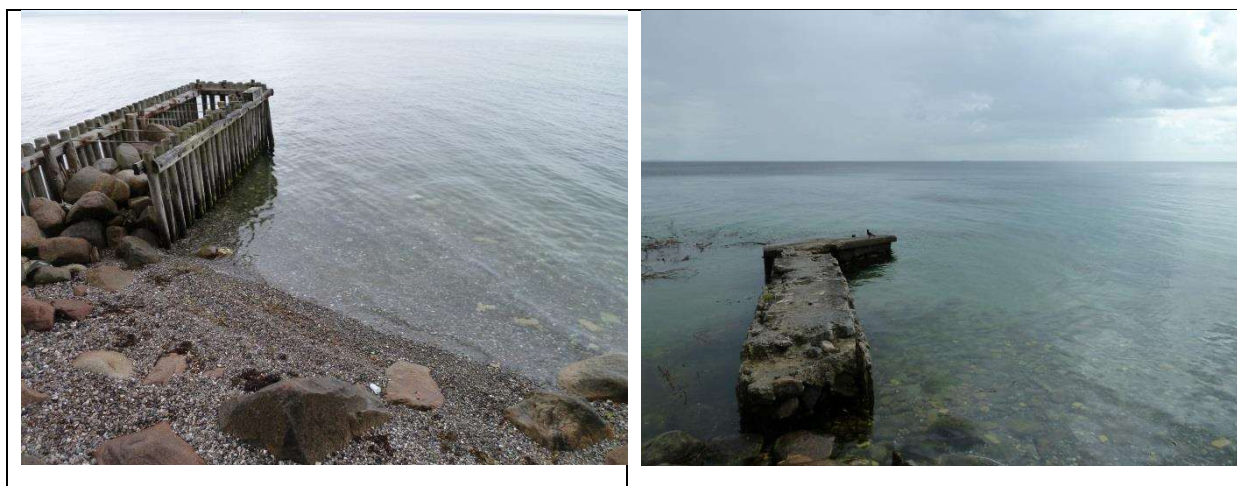
Figur 9 Pælehøfde i nordlige del af området og betonhøfde i midterste del af området.
