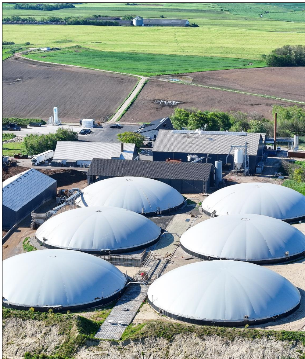
Figur 2 – Dronefoto af Agri Energy Vrå som det ser ud i dag, med de 6 reaktortanke forrest i billedet, og haller til dybstrøelse, fiberseparation og pyrolyseanlæg i baggrunden.
