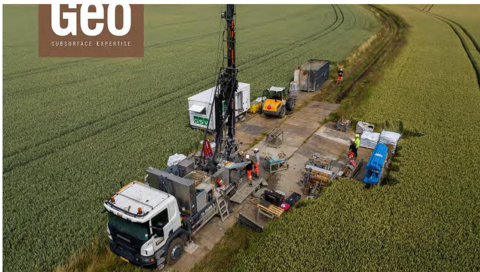
Fig. 3 Arbejdsområde med køreplader inkl. borerig, udstyr, Vandtank og manskabsvogn (fra ansøgningen).
