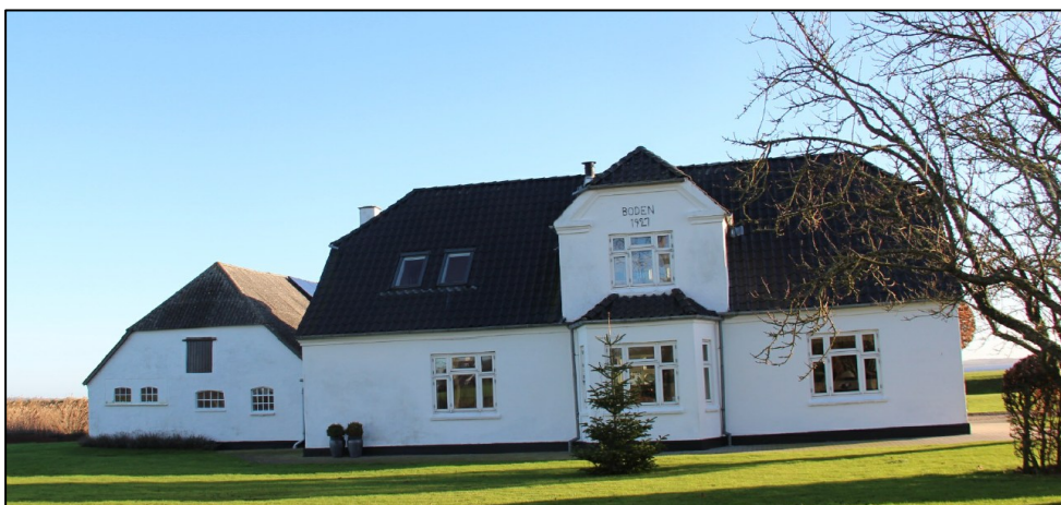
Fig. 3. Tilsendt af ansøger. Eksisterende bygninger set fra vest.
