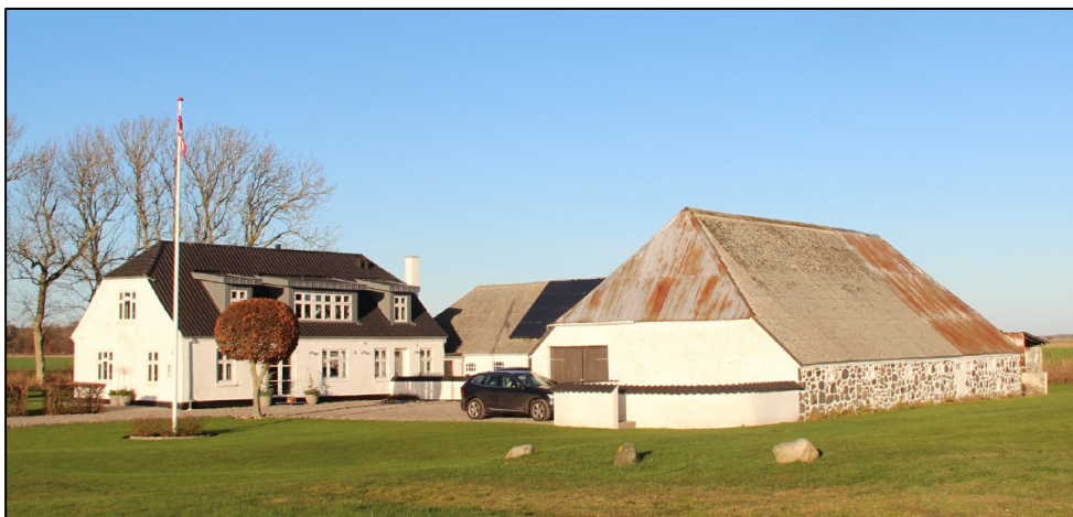
Fig. 2. Tilsendt af ansøger. Eksisterende bygninger set fra syd og øst.
