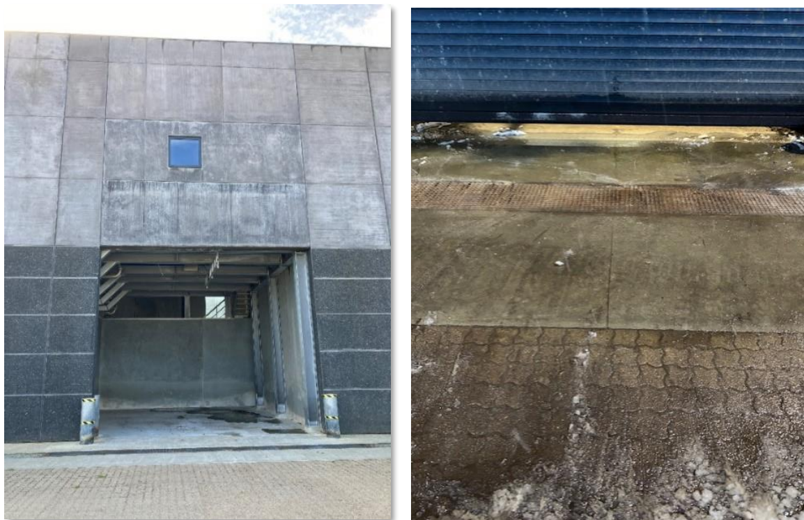
Figur 10: Udleveringsboks med humus og detail af belægning uden for boksen.
