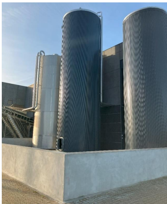
Figur 5: Tank A, B og C med tilhørende tankgård. Tank A, B og C er placeret på et betonelement.
