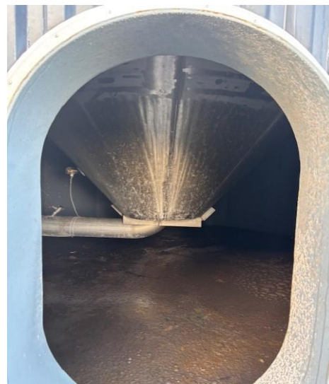
Figur 4 Bunden af tank B kan inspiceres igennem en mandeluge.
