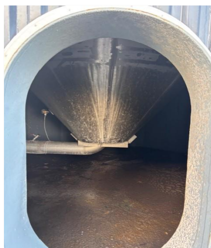
Figur 6 Bunden af tank B kan inspiceres igennem en mandeluge.
