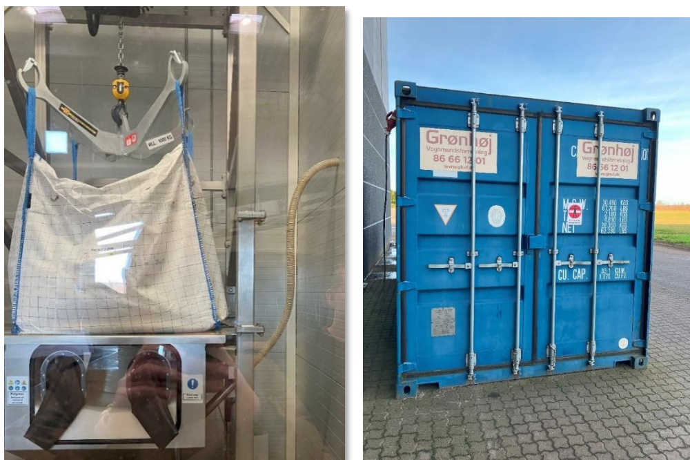
Figur 12: Polymer opbevares i bigbags. Billedet til venstre viser en bigbag placeret på sækketømmere. Dosering af polymer til vandgenbrugsanlægget sker i et lukket system. Til højre ses container til opbevaring af polymer i bigbags.
