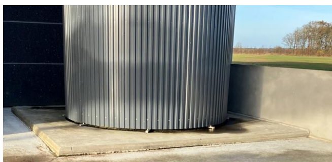
Figur 5: Tank A, B og C med tilhørende tankgård. Tank A, B og C er placeret på et betonelement.
