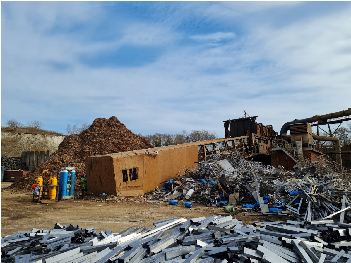
Figur 3 Fødebånd til Shredder hvor formaterialer lægges af en grabkran, set fra pladsen hvor formaterialer læsses af
