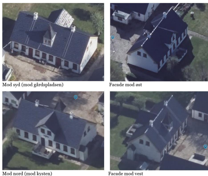
Fig. 5. Facadebilleder af det eksisterende stuehus.
