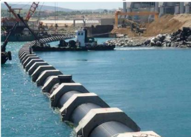
Figur: Eksempel på stor PEH ledning med monterede ballastklodser (Kilde: Pipelife.com)
