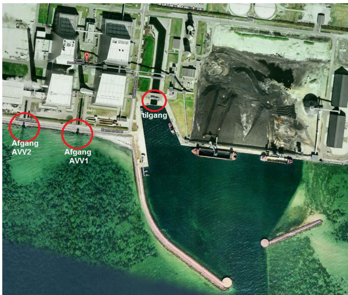
Kølevandsindtaget og de to kølevandsudløb fra blok 1 og blok 2
