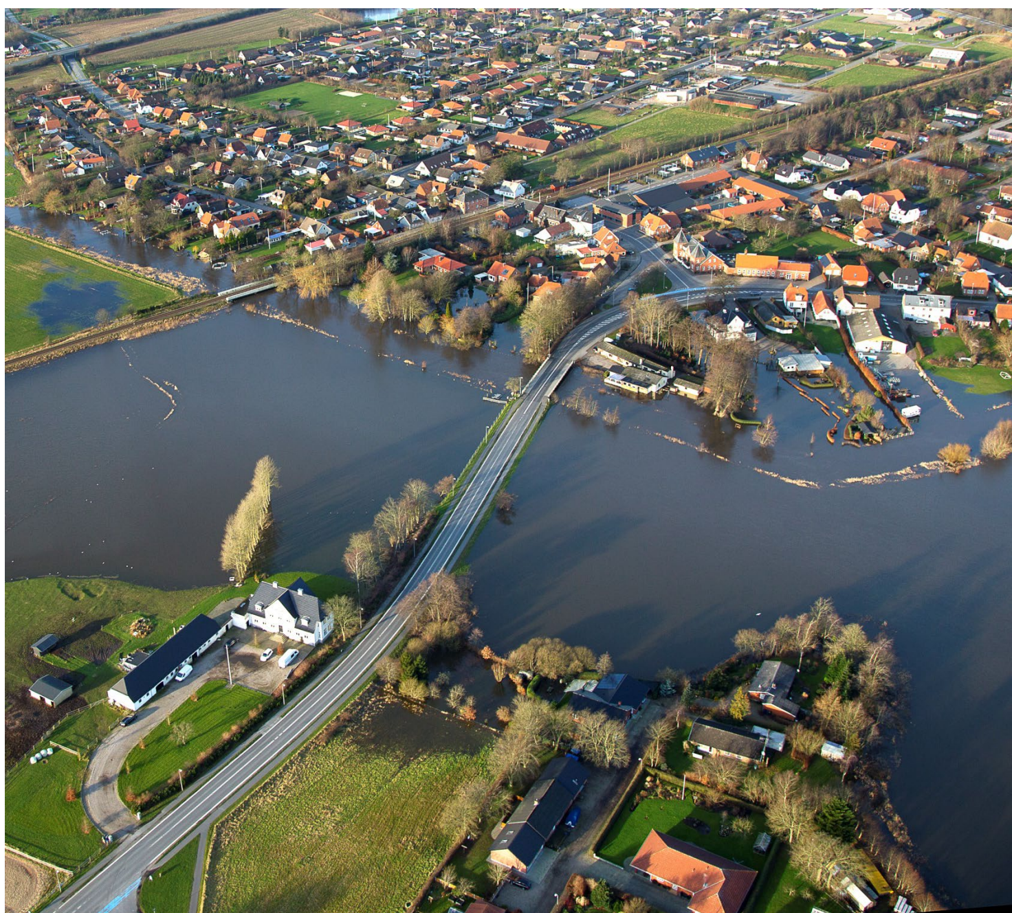
Oversvømmelse fra Kongeåen ved Gredstedbro, Esbjerg, d. 28. december 2015. Fotograf: AT Luftfoto
