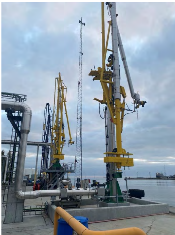
Figur 6 Eksempel på marine loading arm
