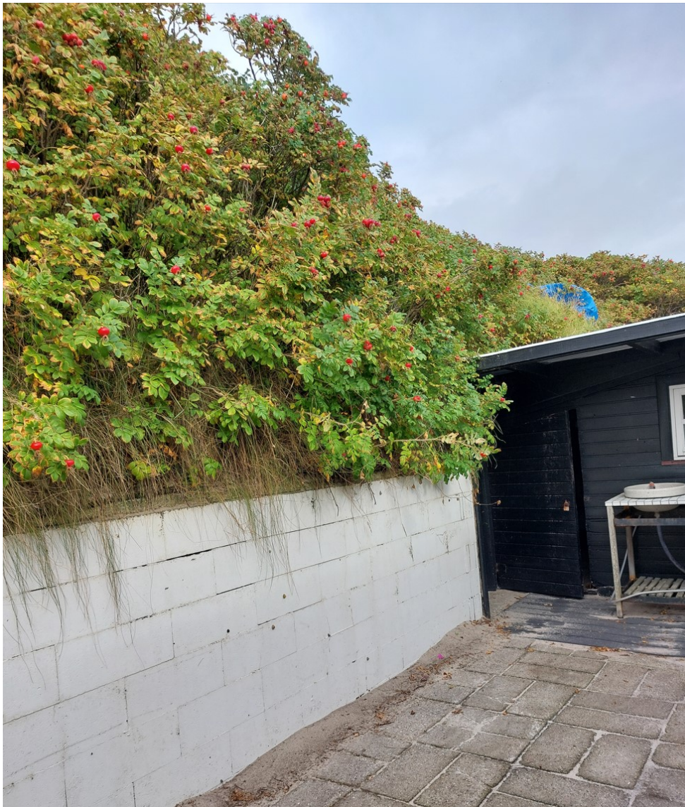
Fig. 6. Billede taget på besigtigelse af ejendommene d. 16-09-2024. På figuren ses et billede fra Bjerghuse 60, hvor man kan se at klitten er vokset meget højt op langs ejendommen.
