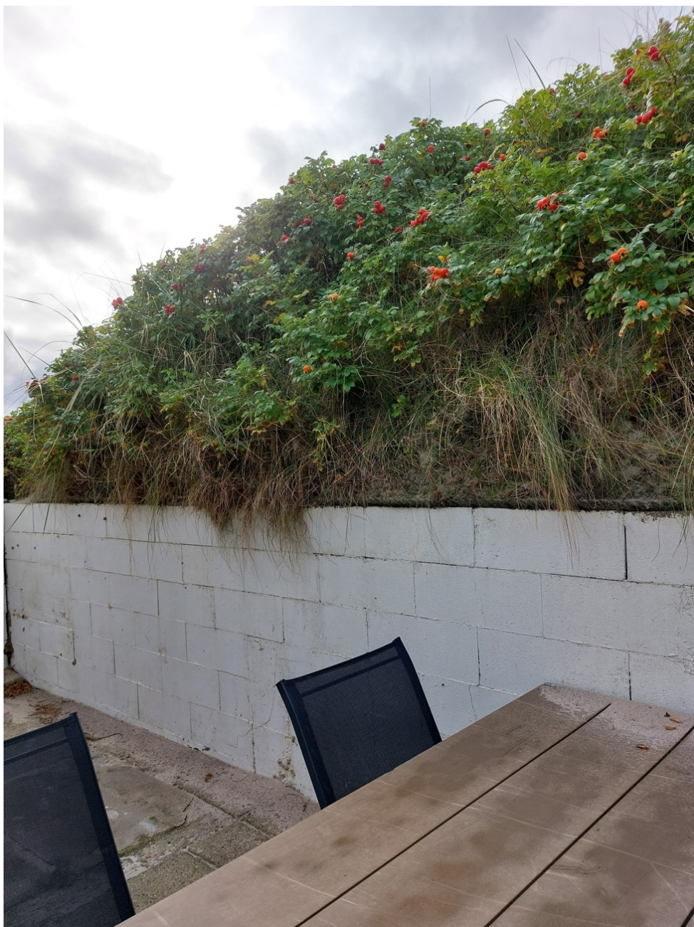
Fig. 8. Billede taget på besigtigelse af ejendommene d. 16-09-2024. På figuren ses et billede fra Bjerghuse 60, der er taget ind mod Bjerghuset 61.
