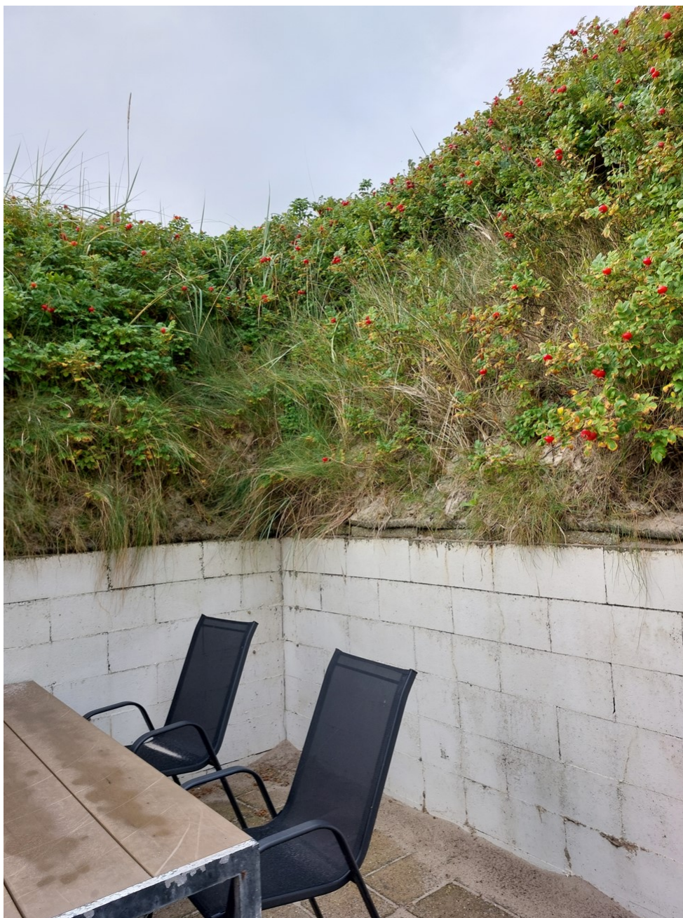
Fig. 5. Billede taget på besigtigelse af ejendommene d. 16-09-2024. På figuren ses et billede fra Bjerghuse 60, hvor man kan se at klitten er vokset meget højt op af støttemuren rundt om ejendommen.
