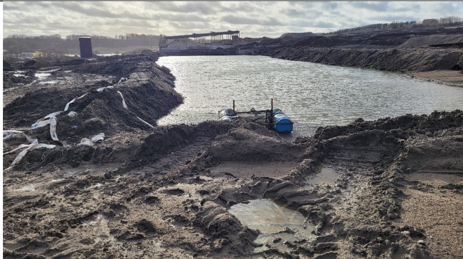
Klargøring til pumpning fra stort overfladevandsbassin for at undgå afstrømning og med henblik på forrensning
