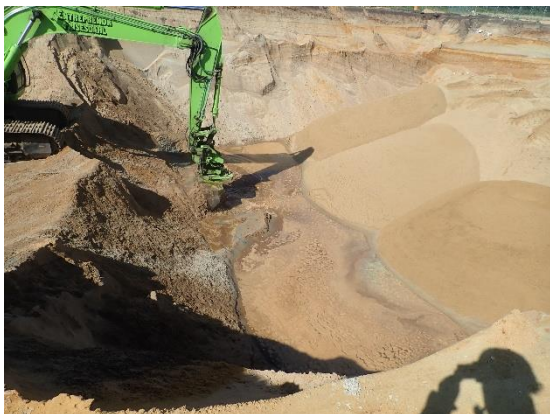
#3 Bund af udgravning ved 4.3, nordlig del af rende, set fra øst.
