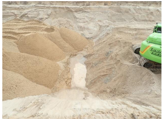
#10 Bund af udgravning ved 3.12, sydlig del af rende, set fra vest.
