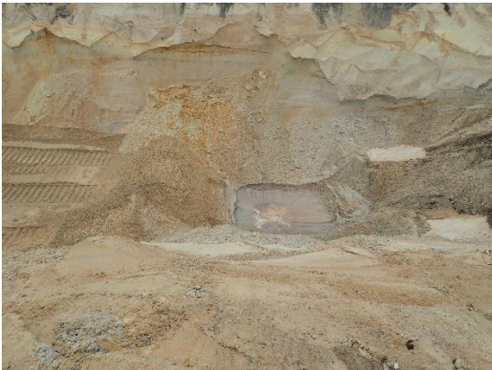
#5 Bund af udgravning ved 5.6, central del af rende, set fra vest.
