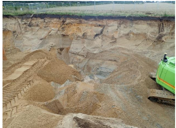
#2 Bund af udgravning ved 1.2, central del af rende, set fra syd.
