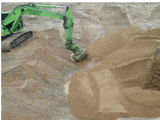
#5 Bund af udgravning ved 3.7, central del af rende, set fra vest.
