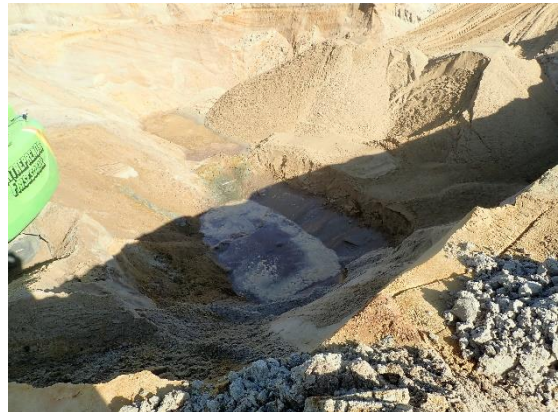
#2 Bund af udgravning ved 4.2, nordlig del af rende, set fra øst.
