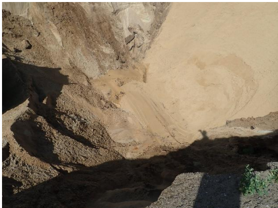
#9 Bund af udgravning ved 5.12, sydlig del af rende, set fra vest.
