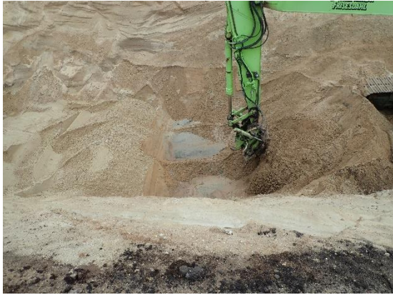
#7 Bund af udgravning ved 5.9, central del af rende, set fra vest.
