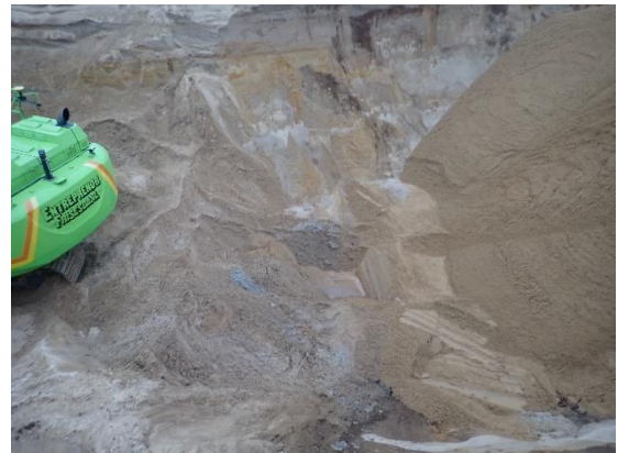
#10 Bund af udgravning ved 5.13, sydlig del af rende, set fra vest.
