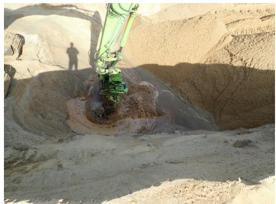
#4 Bund af udgravning ved 4.4, nordlig del af rende, set fra øst.
