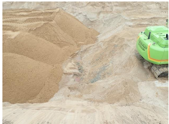
#12 Bund af udgravning ved 3.14, sydlig del af rende, set fra vest.
