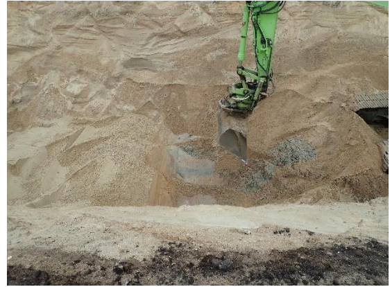
#8 Bund af udgravning ved 5.10, central del af rende, set fra vest.
