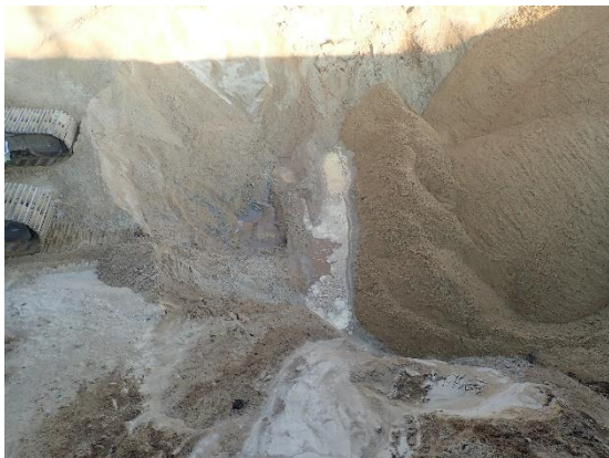
#11 Bund af udgravning ved 5.14, sydlig del af rende, set fra vest.
