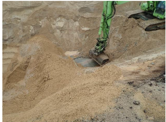
#6 Bund af udgravning ved 5.8, central del af rende, set fra vest.
