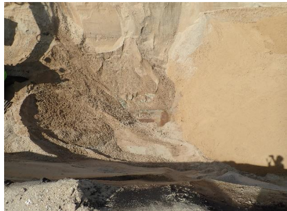
#4 Bund af udgravning ved 2.4, nordlig del af rende, set fra øst.
