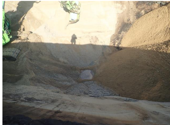
#2 Bund af udgravning ved 2.2, nordlig del af rende, set fra øst.
