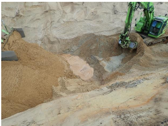
#3 Bund af udgravning ved 1.3, central del af rende, set fra syd.
