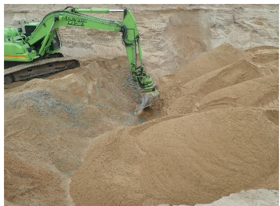
#6 Bund af udgravning ved 3.8, central del af rende, set fra vest.
