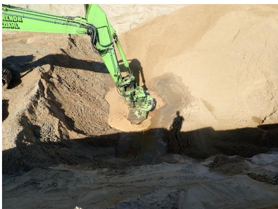
#5 Bund af udgravning ved 4.5, nordlig del af rende, set fra øst.
