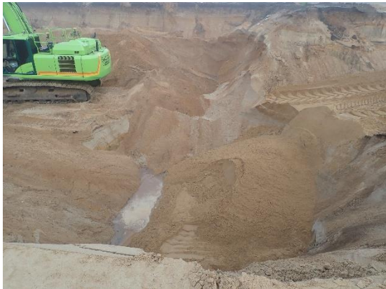
#1 Bund af udgravning ved 4.1, nordlig del af rende, set fra øst.
