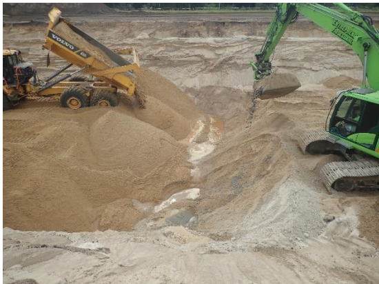
#9 Bund af udgravning ved 3.11, sydlig del af rende, set fra vest.
