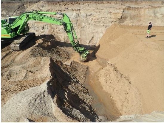
#7 Bund af udgravning ved 3.9, central del af rende, set fra vest.
