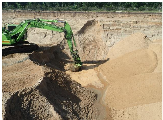
#4 Bund af udgravning ved 3.6, central del af rende, set fra vest.
