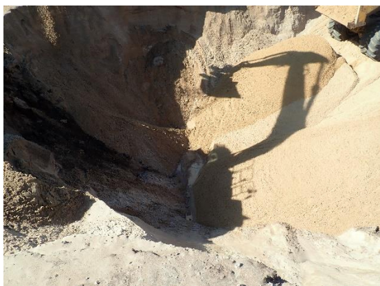
#13 Bund af udgravning ved 5.16, sydlig del af rende, set fra vest.
