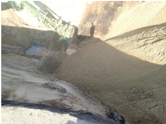
#1 Bund af udgravning ved 2.1, nordlig del af rende, set fra øst.
