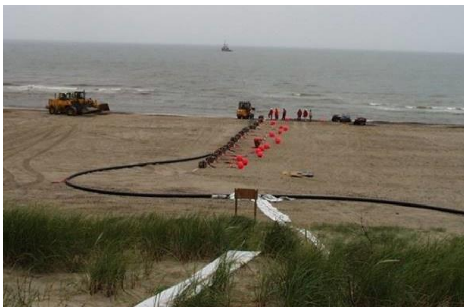
Figur 4 Eksempel på udledningsslange ved Vesterhavet. Slangen trækkes ud til den ønskede dybde ud for afslutningen på gasrørledningen.
