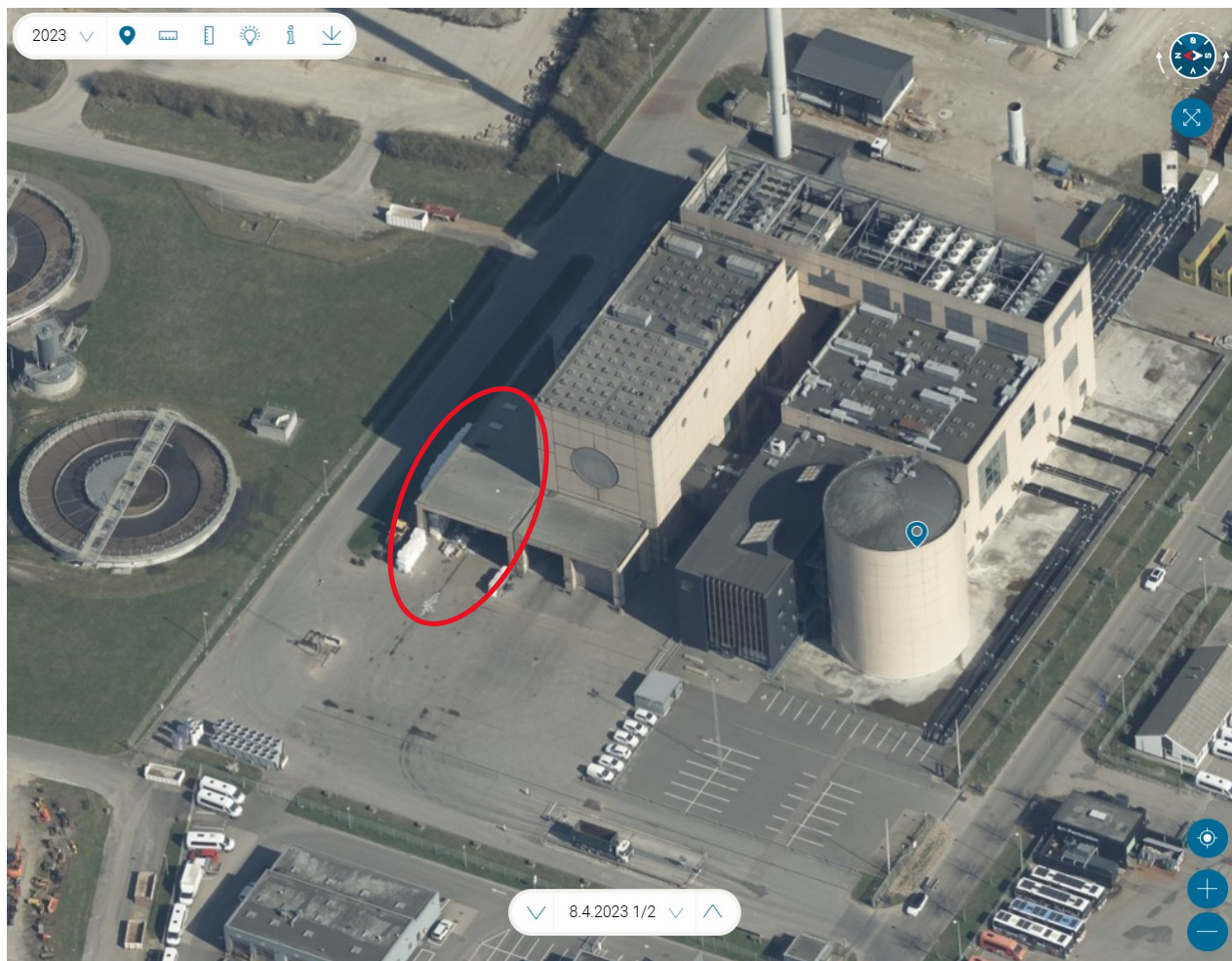
Figur 7 figuren viser området for Fjernvarme Horsens neddeler hal, markeret med rød (Kort fra skråfoto)
