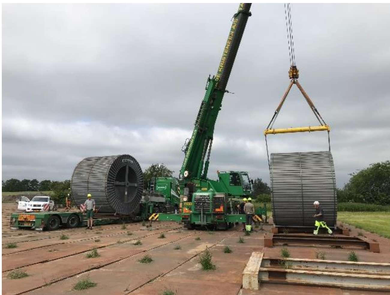
Figur 2-9 Håndtering af kabeltromler på tromleplads
