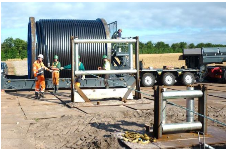
Figur 2-15 Kabeltromle på blokvogn
