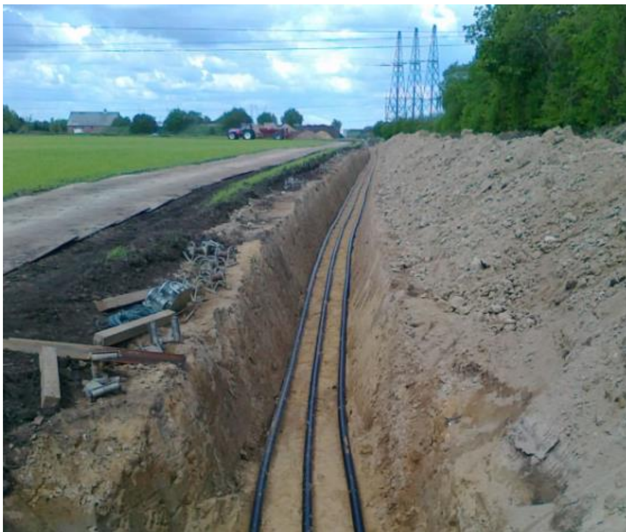
Figur 2-6 Kabelanlæg lagt ud i åben grav
