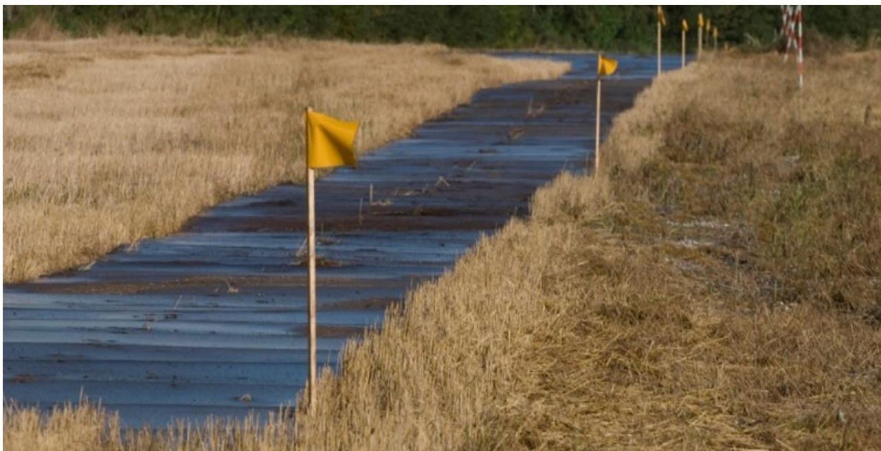
Figur 2-11 adgangsvej med køreplader
