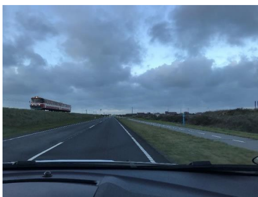
Den østlige del af Harboøre Tange består af et dæmningsanlæg med vej og jernbane.
