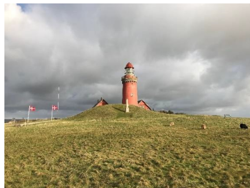
Bovbjerg Fyr udgør et markant landmærke på den høje kystkrint.
