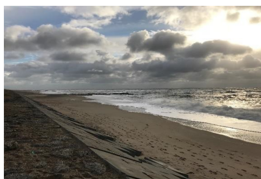
Kystbeskyttelse i den sydlige del af karakterområdet med hofder og skråningsbeskyttelse.
