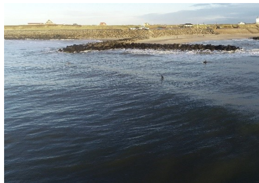
Figur 5-17. Luftfotoets forgrund udgøres af hofde Q. Til venstre for hofden ses skråningsbeskyttelse, mens til højre ses bølgebrydere langs det lave, smalle klitlandskab. Bagved klitlandskabet ses det træløse jordbrugslandskab på en bakkeø.
