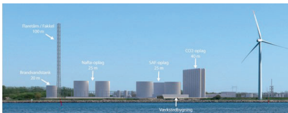
Visualisering set fra sydvest med værkstedsbygningen der er vist med en højde på ca. 6 m – del af den kan opføres med op til 15 m højde.
