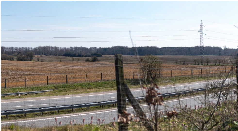
Motorvejsbro, Højbjergvej kik mod øst ud over eksisterende marker og 400 kV luftledning
