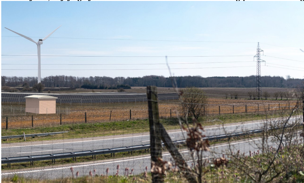
År 1. efter anlæg kik ud over transformator, vindmølle højde 150 m, solceller max. 5,2 m
