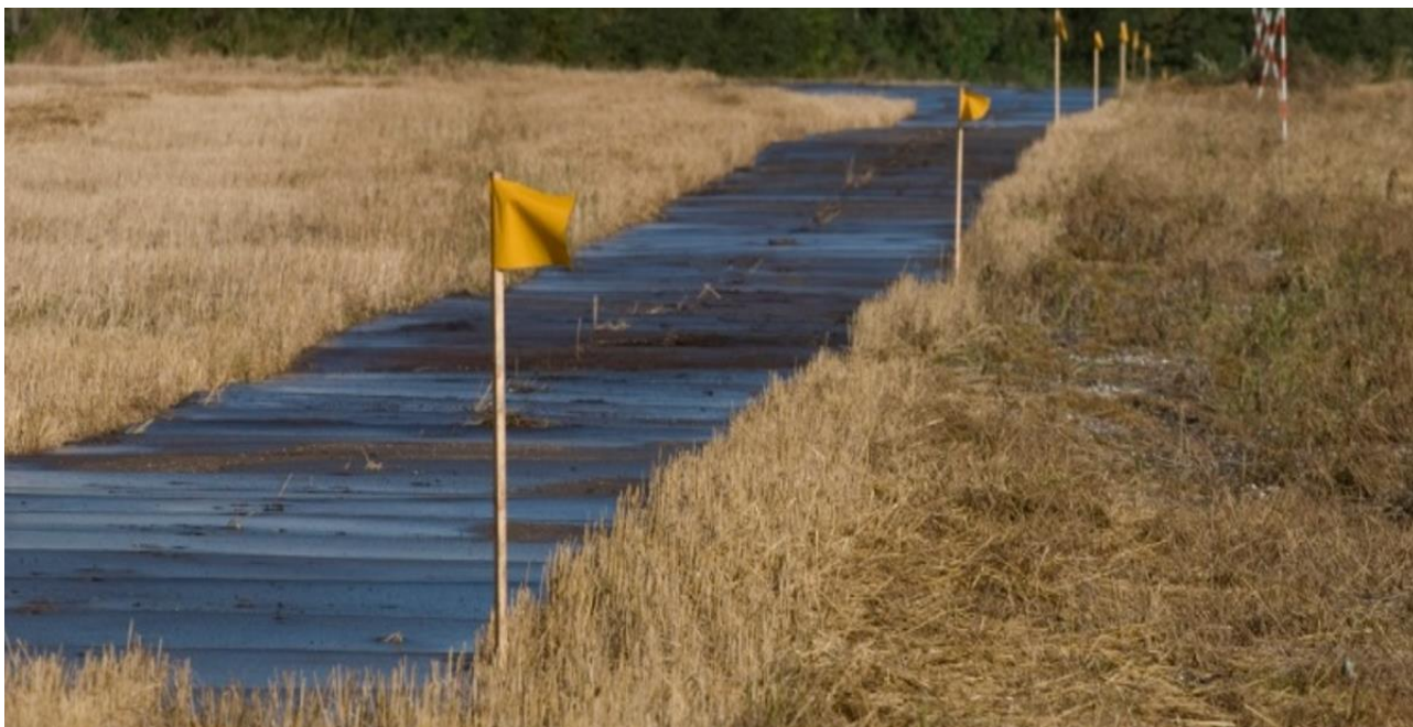
Figur 2-11 adgangsvej med køreplader
