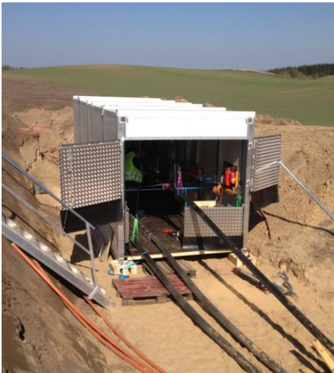
Figur 2-7 Container til montering af muffe
