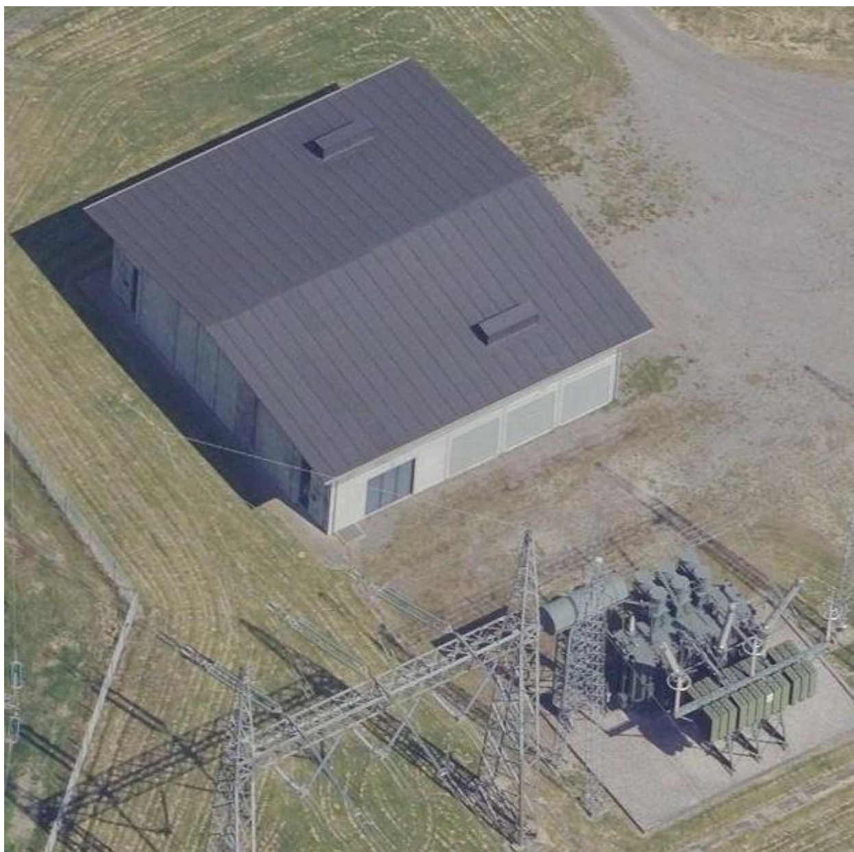
Figur 4-3. Eksempel på en bygning indeholdende et 220 kV-gasisoleret kompakt indendørs koblingsanlæg (GIS).
