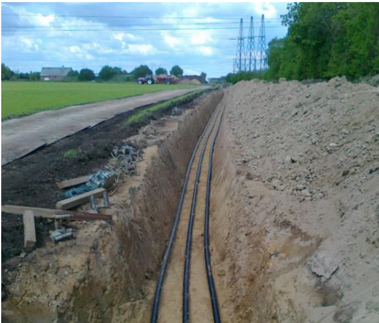
Figur 2-6 Kabelanlæg lagt ud i åben grav
