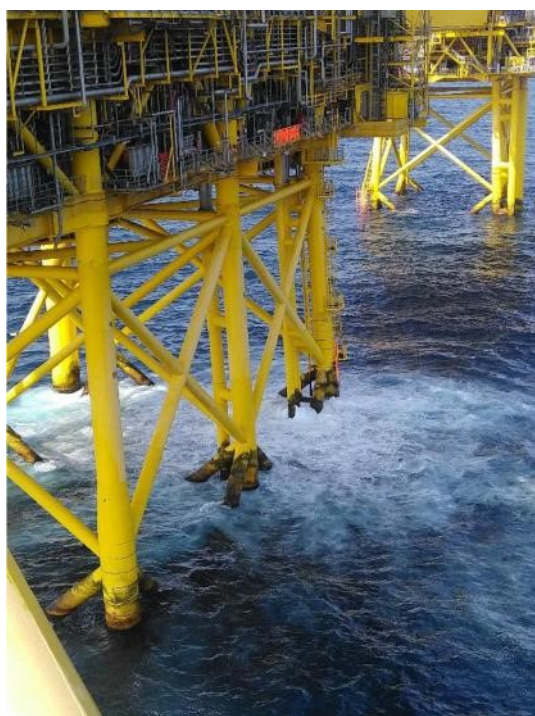
Udledningspunkt fra Tyra East – 9 meter under havets overflade
