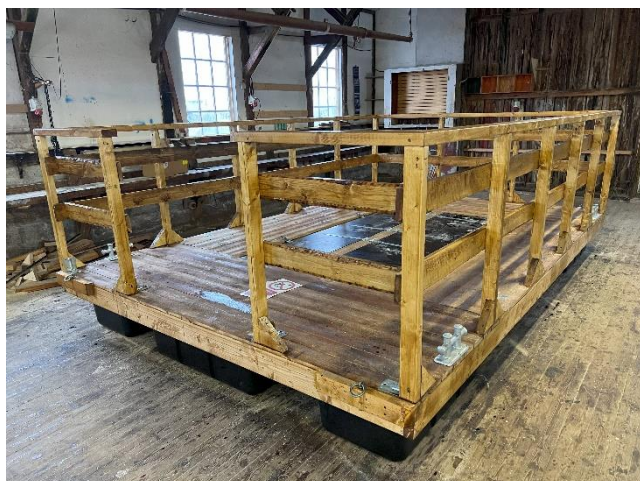
Figur 1 Platformen under konstruktion
