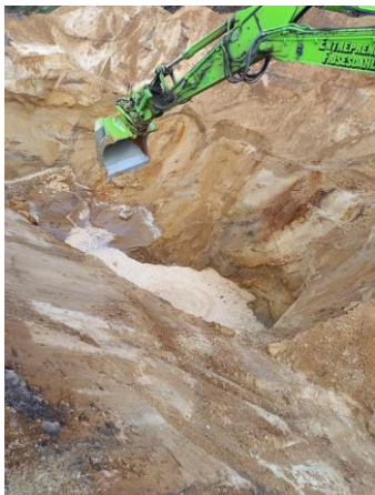
#1 5.1.1: Taget fra syd. Der ses bund, østlig- og vestligkanter. Afgravning til terrænnært grundvand.
