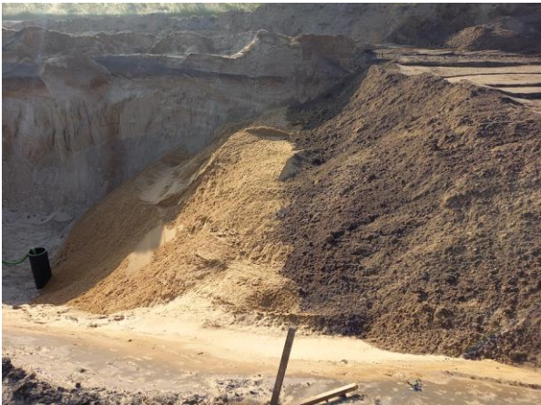
#11 5.3.1: Taget fra vest. Der ses bund og østligkant. Etableret brønd til oppumpning af regnvand.
