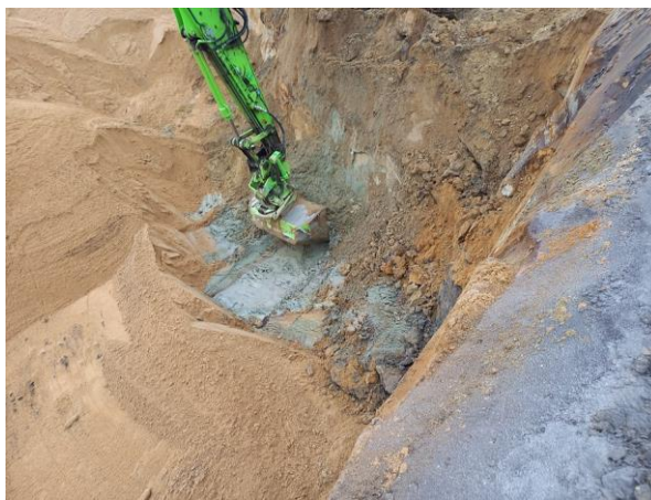
#10 7.3.5: Taget fra øst. Der ses bund, og østligkanter
