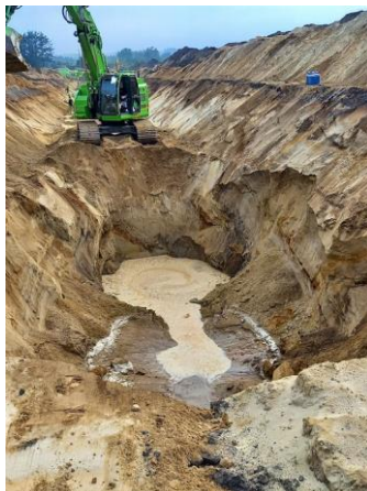
#2 5.1.2: Taget fra syd. Der ses bund, østlig- og vestligkanter. Afgravning til terrænnært grundvand.
