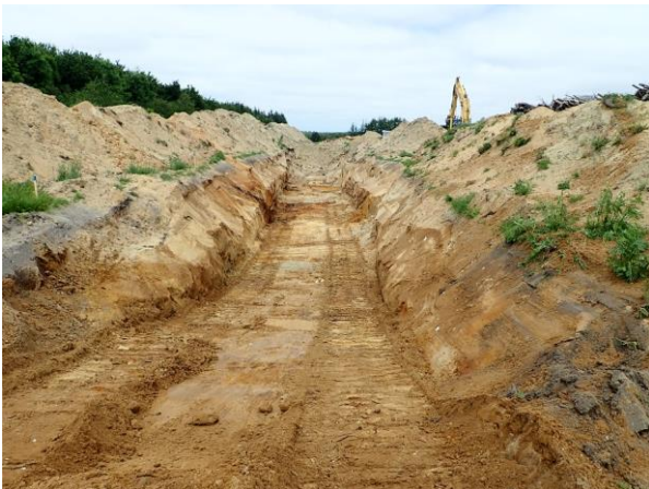
#5 R2 Syd: Taget fra syd. Der ses bund, østlig- og vestligkanter
