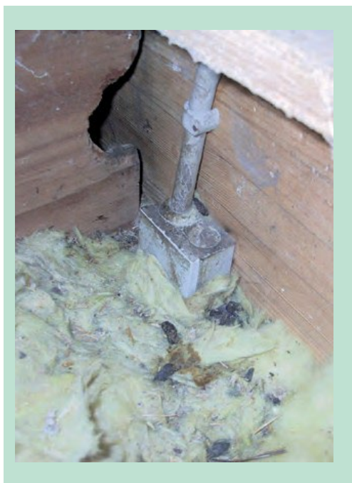
FIGUR 19. Huller og brune belægninger indendørs er med til hurtigt at afsløre gnaveraktivitet.
