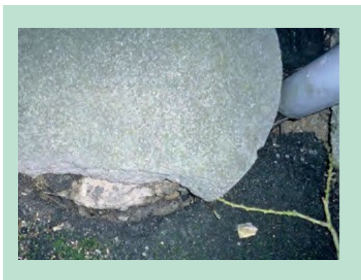
FIGUR 27. Defekte tagbrønde er en kilde til rotteangreb.
