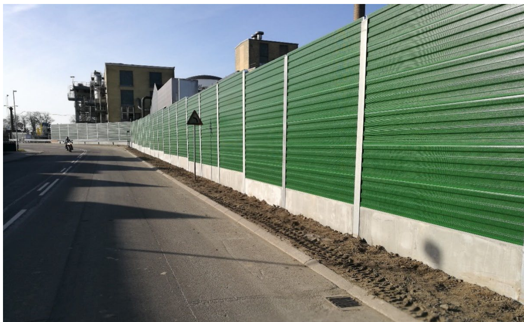
Figur 4 Støjskærm langs Tollesensvej etableret i 2018/19.
