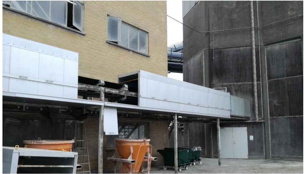
Figur 5 Bullerhus der er etableret omkring transportbånd mellem kalksilo og kalkovn. Den midterste sektion er demonteret.
