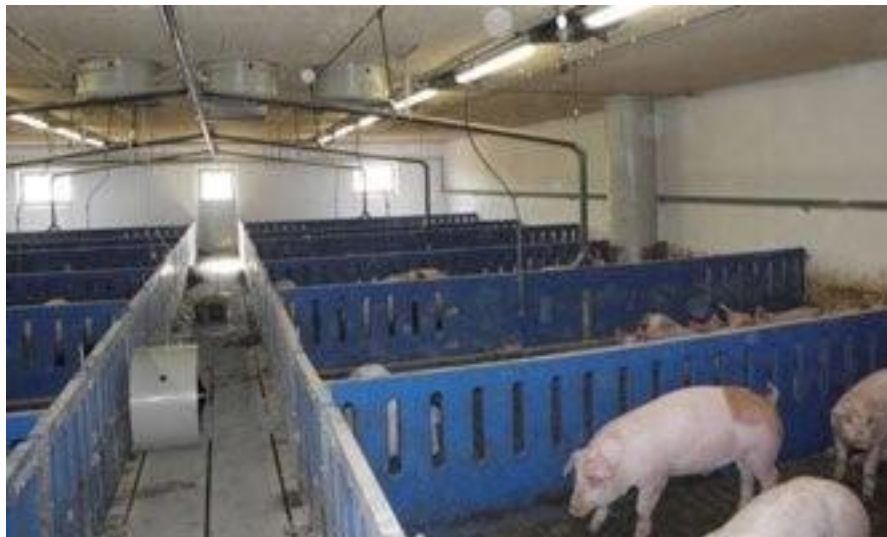
Figur 2. Eksempel på slagtesvinestald med fulddrænet gulv og gylle under midtergang.
