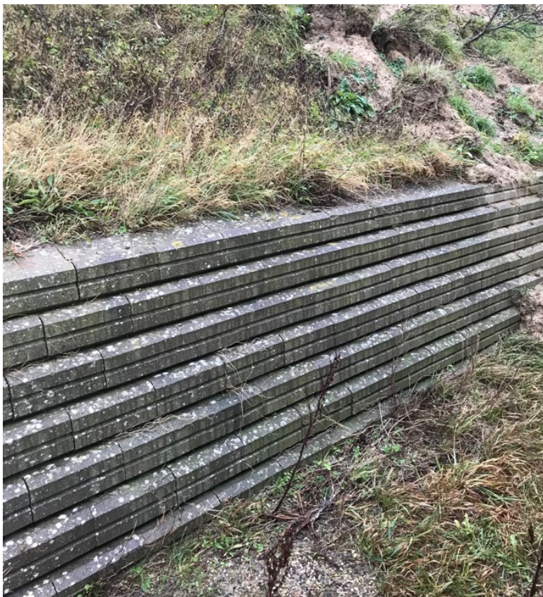
Foto af tilsvarende støttemur på naboejendommen
