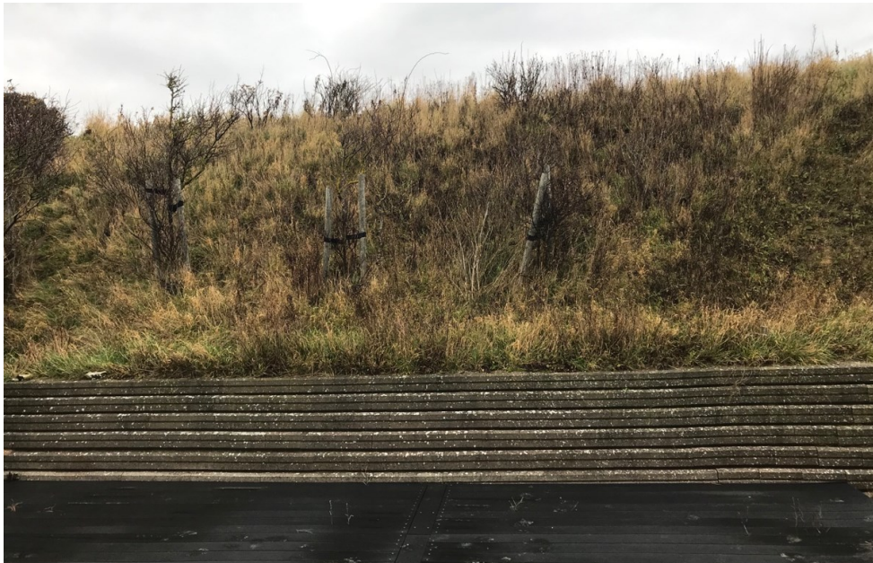
Foto af tilsvarende støttemur på naboejendommen
