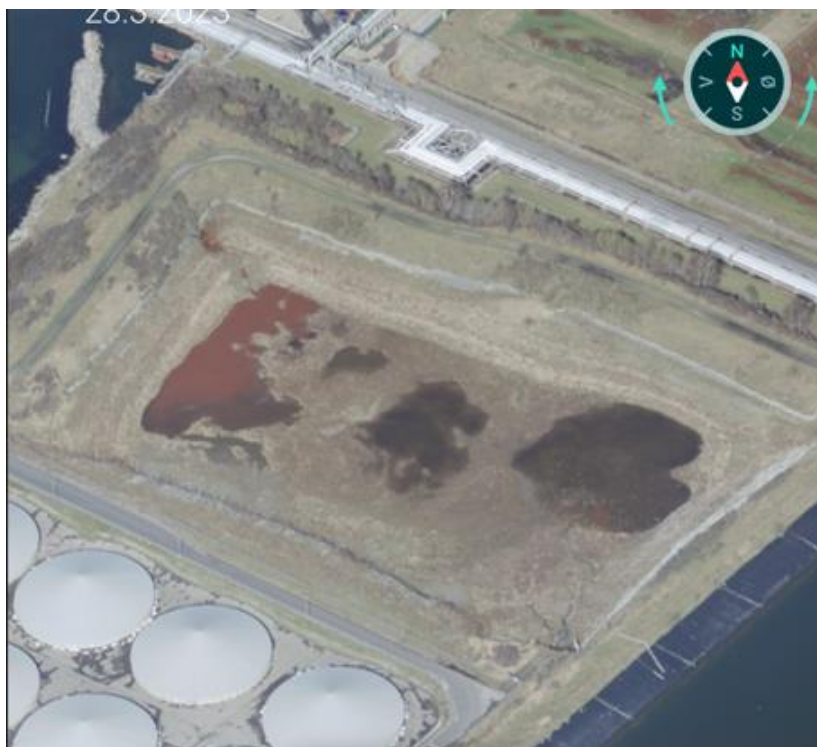
Figur 14: Billede af klaringsbassin for 2023 med tydelige aflejringer af okker, kilde: skraafoto.dataforsyningen.dk
