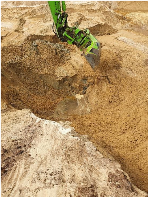
#1 Afgravning til top gvs. ved 13.2.
