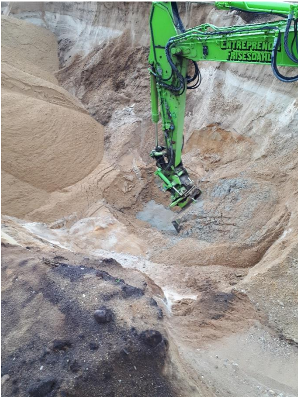
#3 Bund af udgravning ved 10.5, central del af rende, set fra øst.
