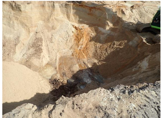
#2 Bund af udgravning ved 12.2, nordlig del af rende, set fra vest.
