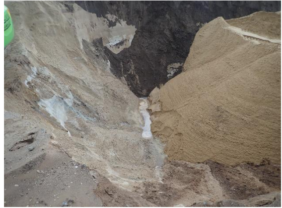
#14 Bund af udgravning ved 12.14, central del af rende, set fra vest.
