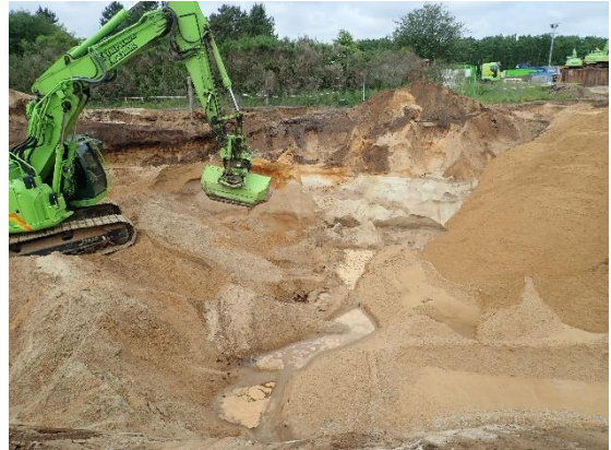
#2 Bund af udgravning ved 6.2, nordlig del af rende, set fra øst.
