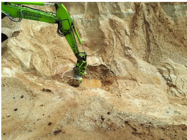
#3 Bund af udgravning ved 7.4, central del af rende, set fra øst.
