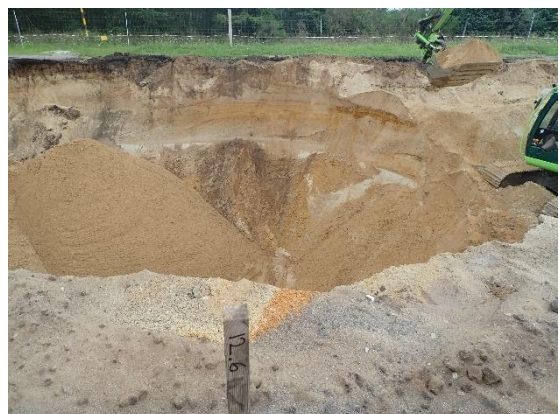
#6 Bund af udgravning ved 12.6, nordlig del af rende, set fra vest.
