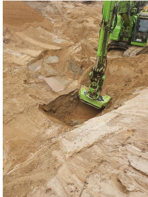
#2 Afgravning til top gvs. ved 14.1.
