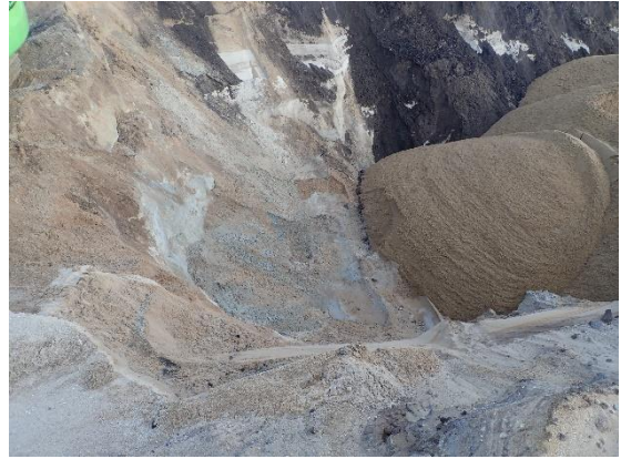
#8 Bund af udgravning ved 11.9, central del af rende, set fra øst.
