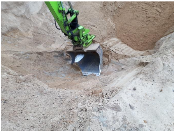
#3 Bund af udgravning ved 8.5, central del af rende, set fra vest.
