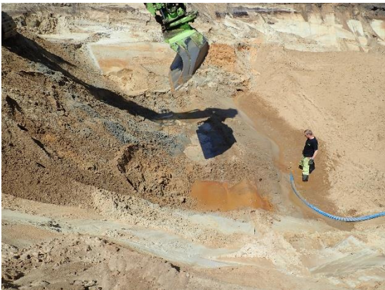
#9 Bund af udgravning ved 6.9, sydlig del af rende, set fra øst.
