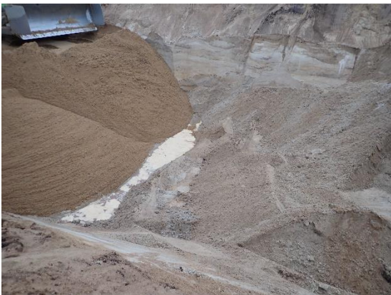
#11 Bund af udgravning ved 12.11, central del af rende, set fra vest.
