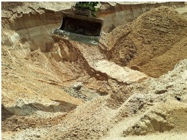
#1 Bund af udgravning ved 8.3, nordlig del af rende, set fra vest.
