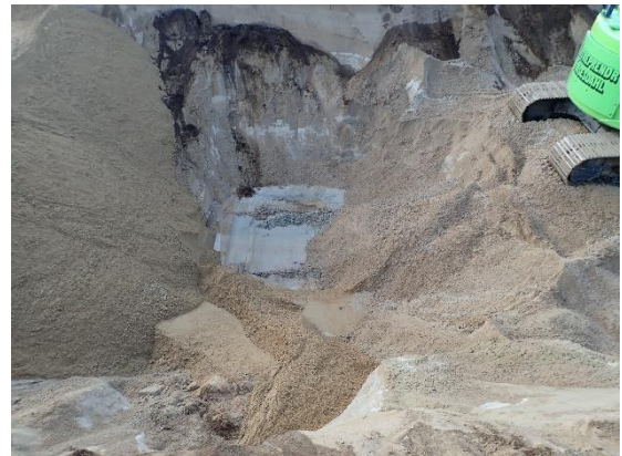
#10 Bund af udgravning ved 12.10, nordlig del af rende, set fra vest.
