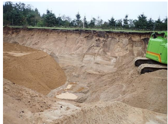
#12 Bund af udgravning ved 12.12, central del af rende, set fra vest.
