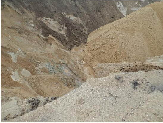
#7 Bund af udgravning ved 11.8, central del af rende, set fra øst.
