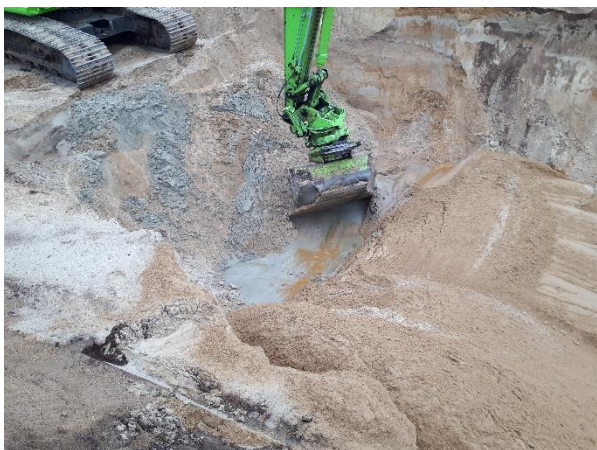
#5 Bund af udgravning ved 8.7, central del af rende, set fra vest.
