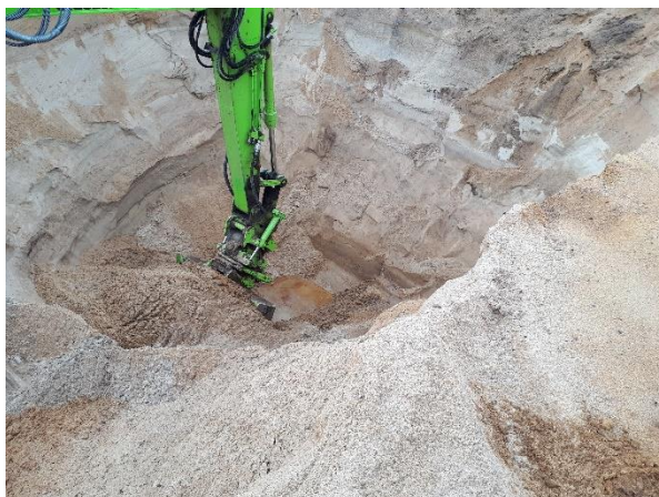
#6 Bund af udgravning ved 7.7, sydlig del af rende, set fra øst.
