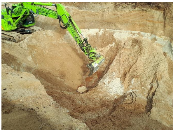
#4 Bund af udgravning ved 7.5, central del af rende, set fra øst.
