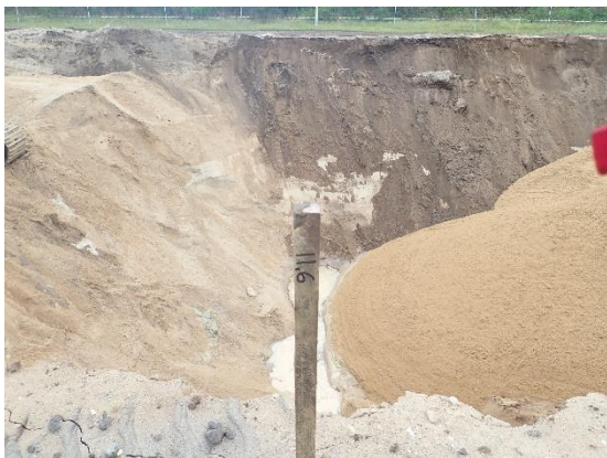
#5 Bund af udgravning ved 11.6, nordlig del af rende, set fra øst.
