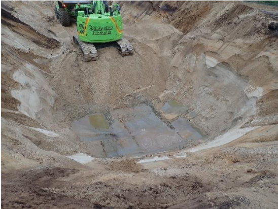
#1 Bund af udgravning ved 6.1, nordlig del af rende, set fra nord.
