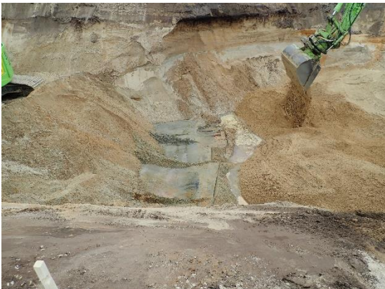
#3 Bund af udgravning ved 6.3, nordlig del af rende, set fra øst.
