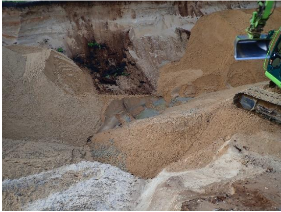
#19 Bund af udgravning ved 12.19, central del af rende, set fra vest.
