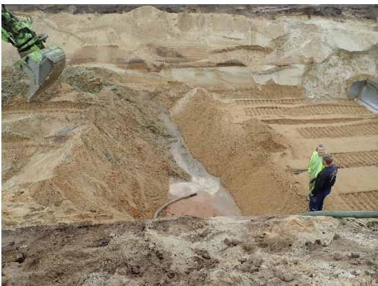
#5 Bund af udgravning ved 6.5, central del af rende, set fra øst.
