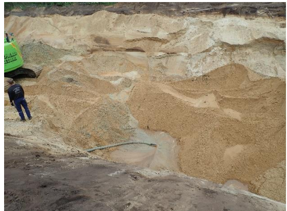
#4 Bund af udgravning ved 6.4, central del af rende, set fra øst.
