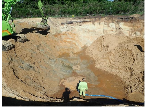
#8 Bund af udgravning ved 6.8, sydlig del af rende, set fra øst.
