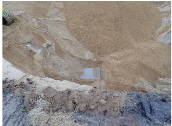
#2 Bund af udgravning ved 11.2, nordlig del af rende, set fra øst.
