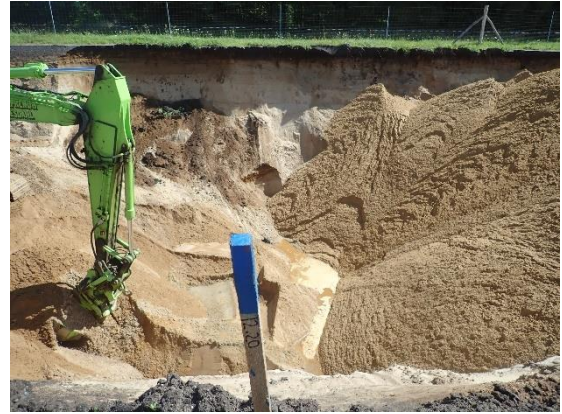
#20 Bund af udgravning ved 12.20, central del af rende, set fra vest.
