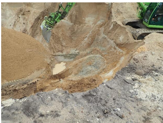
#5 Bund af udgravning ved 12.5, nordlig del af rende, set fra vest.
