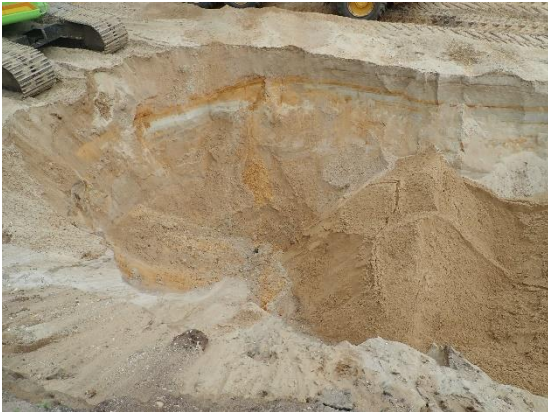
#3 Bund af udgravning ved 9.3, central del af rende, set fra øst.
