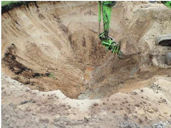
#1 Bund af udgravning ved 12.1, nordlig del af rende, set fra vest.
