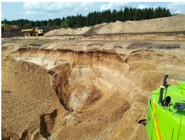
#5 Ekstra afgravning i kant ved 10.6.
