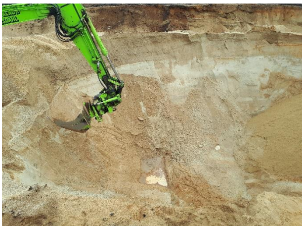
#5 7.6 Bund af udgravning ved 7.6, sydlig del af rende, set fra øst.
