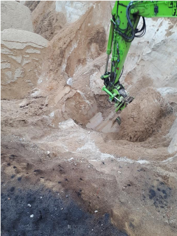
#1 Bund af udgravning ved 10.3, nordlig del af rende, set fra øst.
