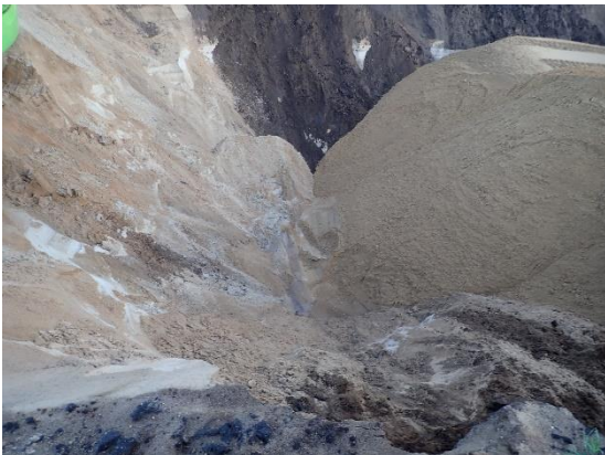
#9 Bund af udgravning ved 11.10, central del af rende, set fra øst.
