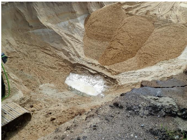
#1 Bund af udgravning ved 7.2, nordlig del af rende, set fra øst.
