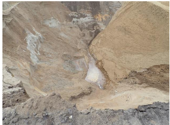
#4 Bund af udgravning ved 11.5, nordlig del af rende, set fra øst.
