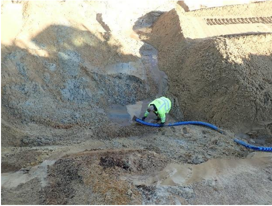
#7 Bund af udgravning ved 6.7, sydlig del af rende, set fra øst.
