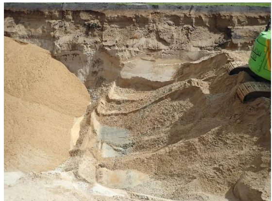
#18 Bund af udgravning ved 12.18, central del af rende, set fra vest.
