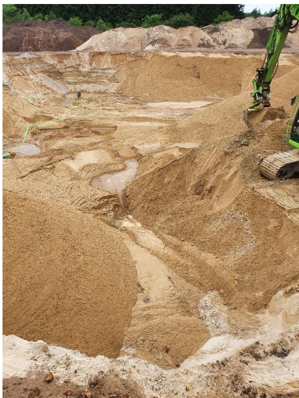
#10 Bund af udgravning ved 10.11, sydlig del af rende, set fra øst., sammengravning med rende 13 og 14.
