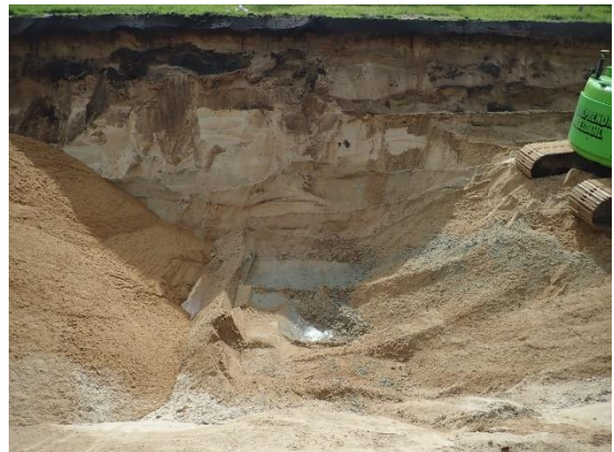
#16 Bund af udgravning ved 12.16, central del af rende, set fra vest.
