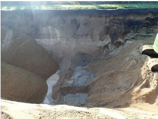
#15 Bund af udgravning ved 12.15, central del af rende, set fra vest.
