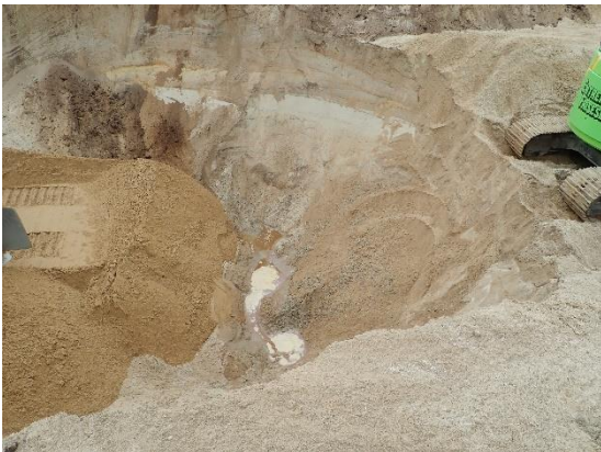
#9 Bund af udgravning ved 12.9, nordlig del af rende, set fra vest.
