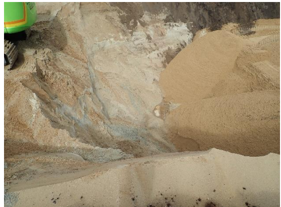
#10 Bund af udgravning ved 11.11, central del af rende, set fra øst.
