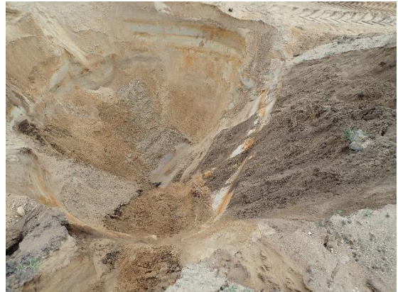
#4 Bund af udgravning ved 9.4, nordlig del af rende, set fra øst.
