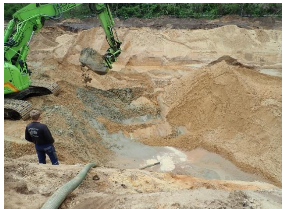
#6 Bund af udgravning ved 6.6, central del af rende, set fra øst.
