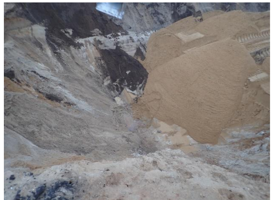
#12 Bund af udgravning ved 11.13, sydlig del af rende, set fra øst.
