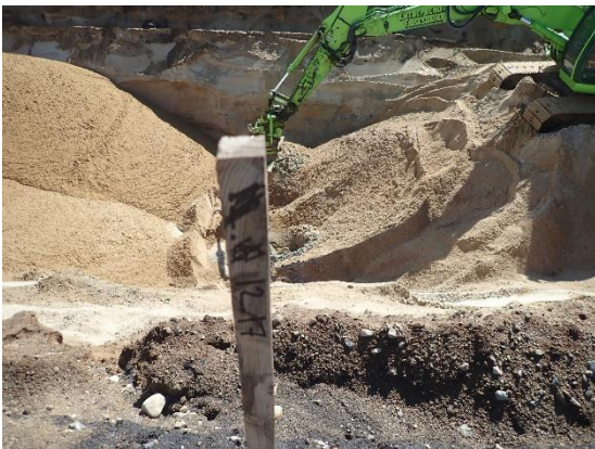
#17 Bund af udgravning ved 12.17, central del af rende, set fra vest.
