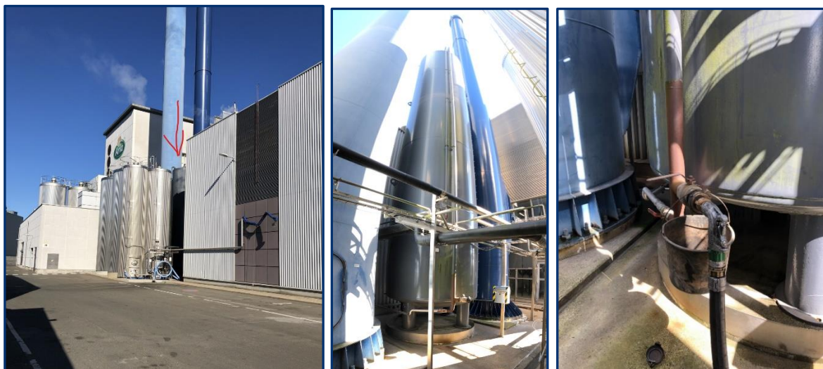
Figur 3-2: Billeder af fyringsolietank (T14). Fremsendt af Arla.
