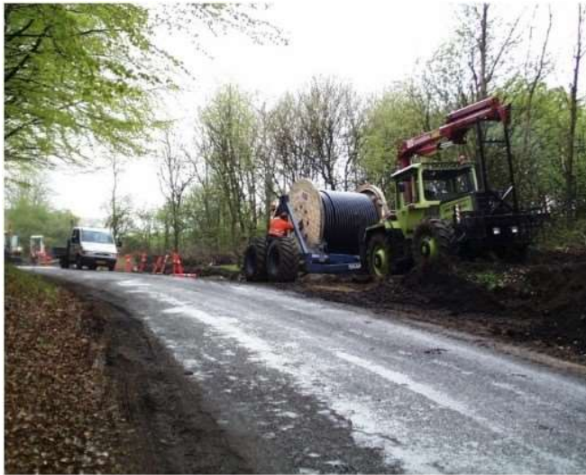
Figur 2 Kabeltromle anbragt i udstyr klar til udtrækning.
