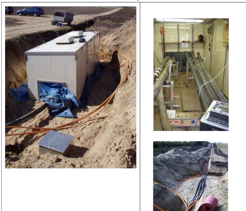
Figur 5 Muffesamlinger og dækplast..
