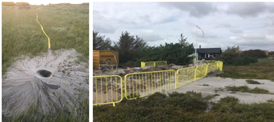
Figur 10 T.v. Udslip af sand og vand på mark. T.h. overløb af boremudder fra bassin
