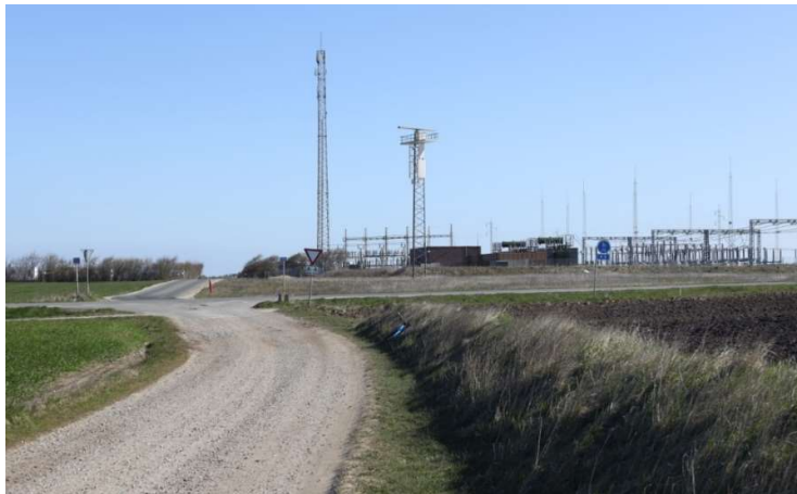
Figur 13 Visualisering af radarmast på stationsområdet ved Søndervig. Radaren placeres i toppen af gittermasten. Masten til venstre er en eksisterende telemast.
