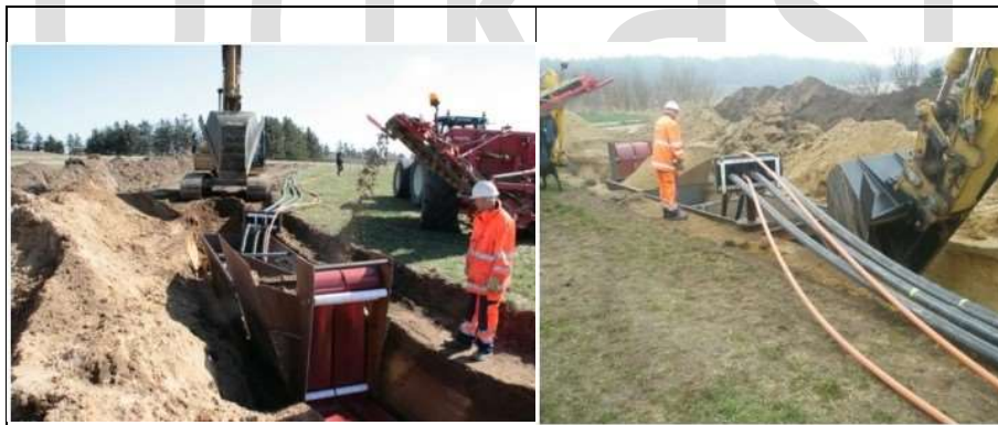
Figur 4 Kabelnedlægning med gravekasse.
