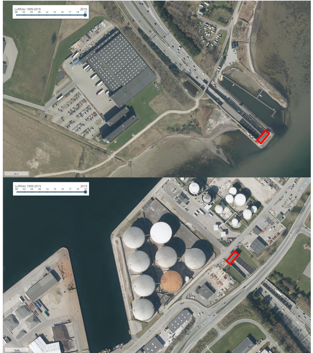
Figur 1-2 Øverst: Nordre rampe og portalbygning.
