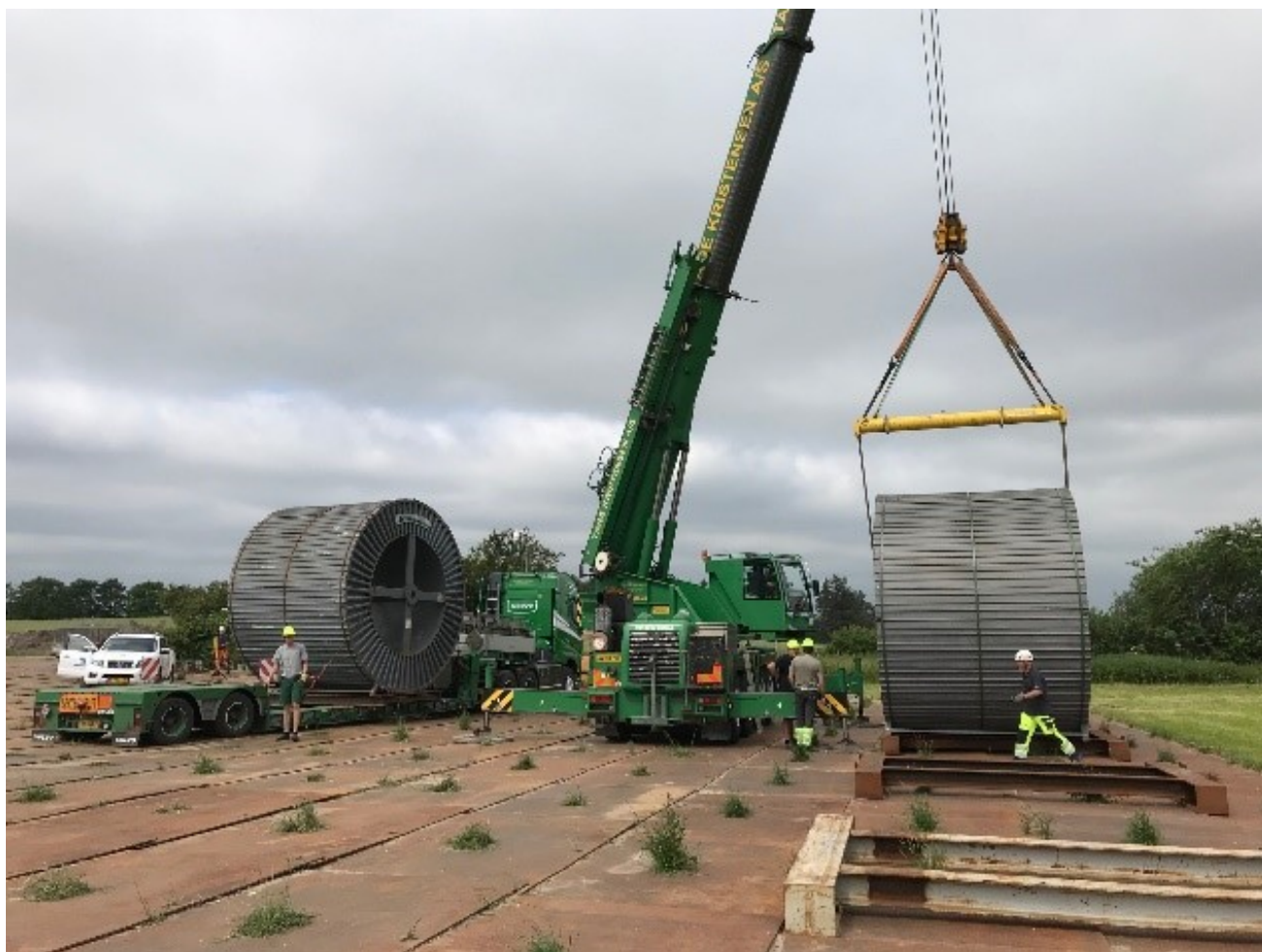
Figur 2-8 Håndtering af kabeltromler på tromleplads
