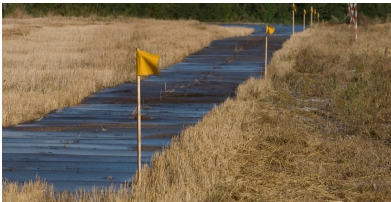
Figur 2-10 adgangsvej med køreplader
