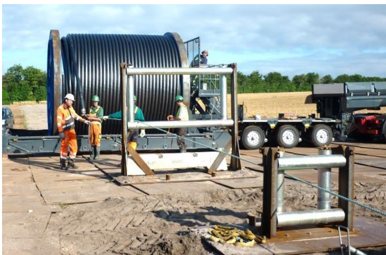
Figur 2-44 Kabeltromle på blokvogn
