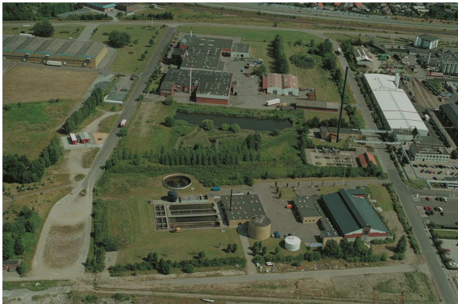
Nyborg Centralrenseanlæg renser spildevandet fra Nyborg By og omegn. Renseanlægget har en godkendt kapacitet på 70.000 PE. Det rensede spildevand fra anlægget udledes via en 620 m lang havledning til det sydlige Storebælt. Fotograf: Jan Kofod Winther.
