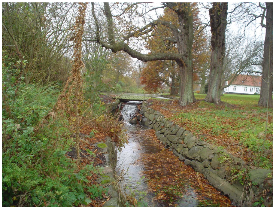
Opstuvning og niveauspring i vandløbsbunden – som ved denne spærring i Grønnemosegrøften - hindrer mange steder faunaens mulighed for frit at vandre op- og nedstrøms i vandløbene. Foto: Jette Hansen.
