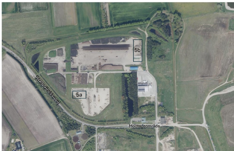
Figur 1: Placering af oplag af brændbart affald på Odense Nord Miljøcenters enhed 5A og 5B.
