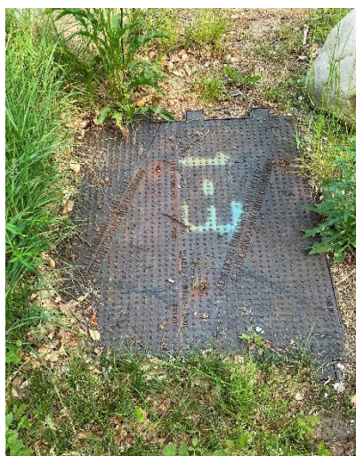
Figur 2-2 Brønddæksel til en linkboksbrønd installeret 2020
