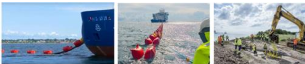
Figur 4-1: Flyd ind af kablet fra kabelskibet med kabelflydere ind i en allerede forberedt rende. (Foto fra NKT-hjemmeside).
