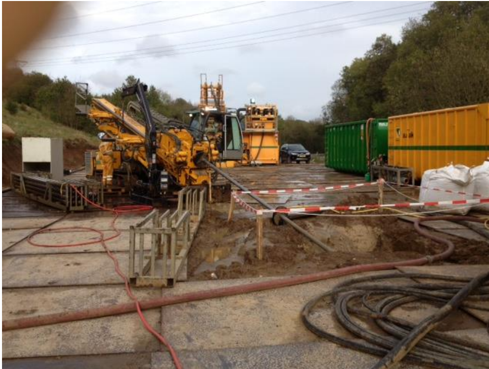
Figur 2-5 Eksempel på et arbejdsareal ved starten af en længere underboring. Herudover ses selve boremaskinen
