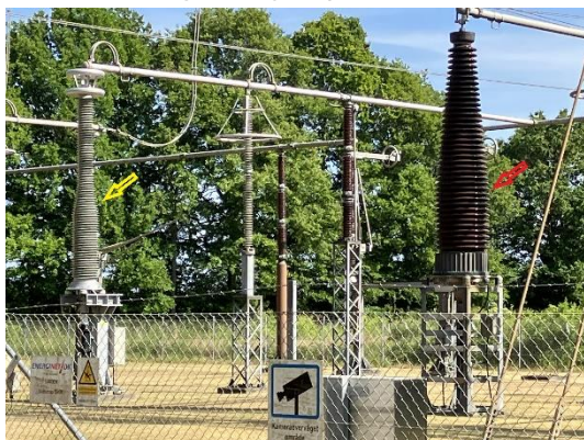
Figur 2-8 Ny fritluftsendemuffe (2020) (gul pil) og gammel, der skal udskiftes (rød pil).
