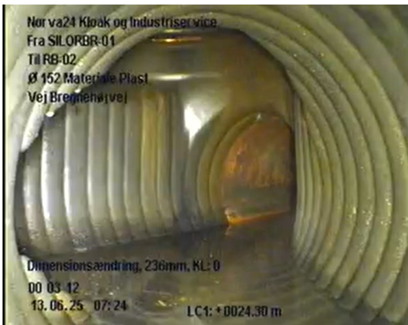
Figur 2 - afbildning af RB-02, som løber fra RB-01, set fra tilgang SILOBR-01 parallelt med kloakstrengen fra RB-06 til 03
