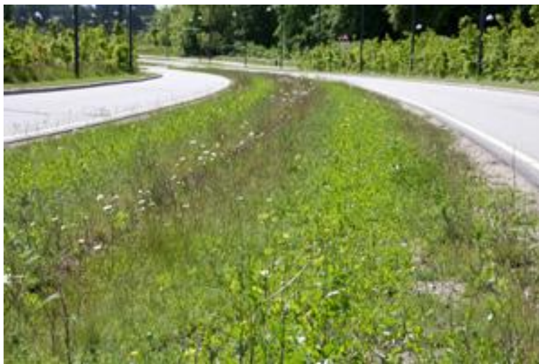
Figur 10-5 Anlagt grøft, foto fra www.erlingholm.com
