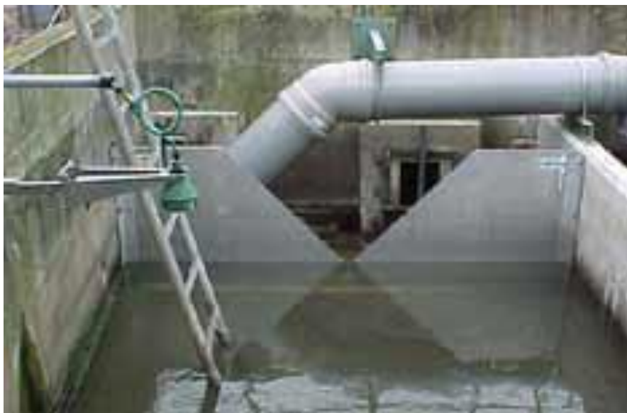
Figur 9-5 Eksempel på vandføringsmåling baseret på trekantet overløb og vandstandsmåling (Kilde: mjk.com)
