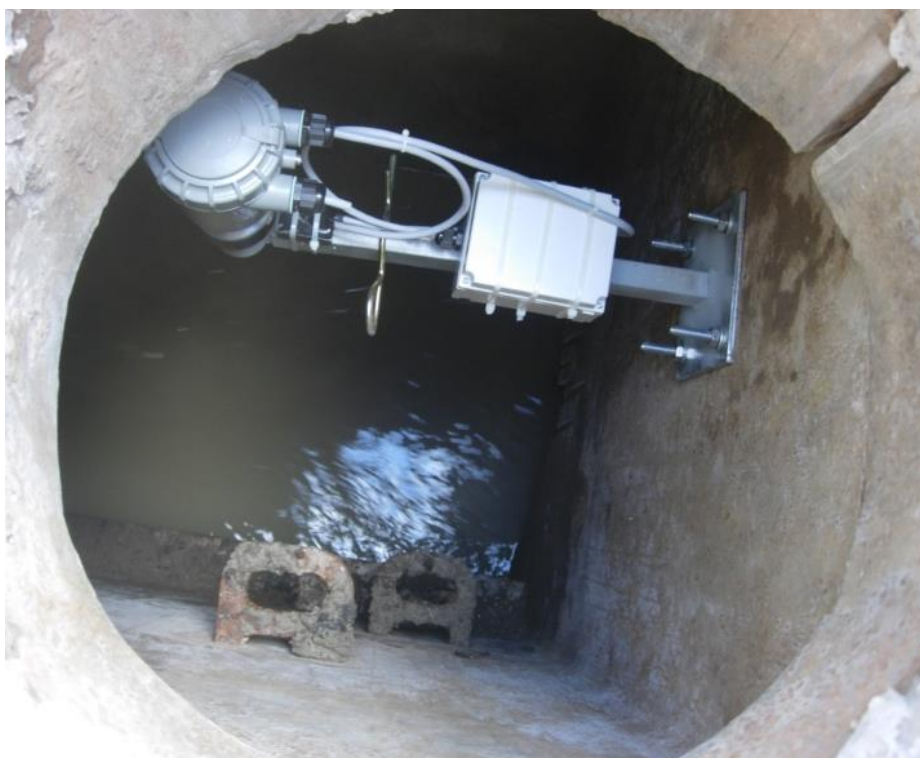
Figur 9-2 Eksempel: Radarsensor placeret over vandspejlet i en kloakbrønd (Kilde: http://www.solidat.net/index.asp )
